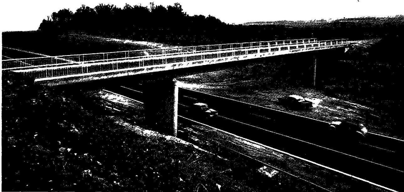
Autoroute A 6 - Paris-Lyon - Passage supérieur du C.V. 3 bis à Sauvigny-le-Bois (Yonne).
