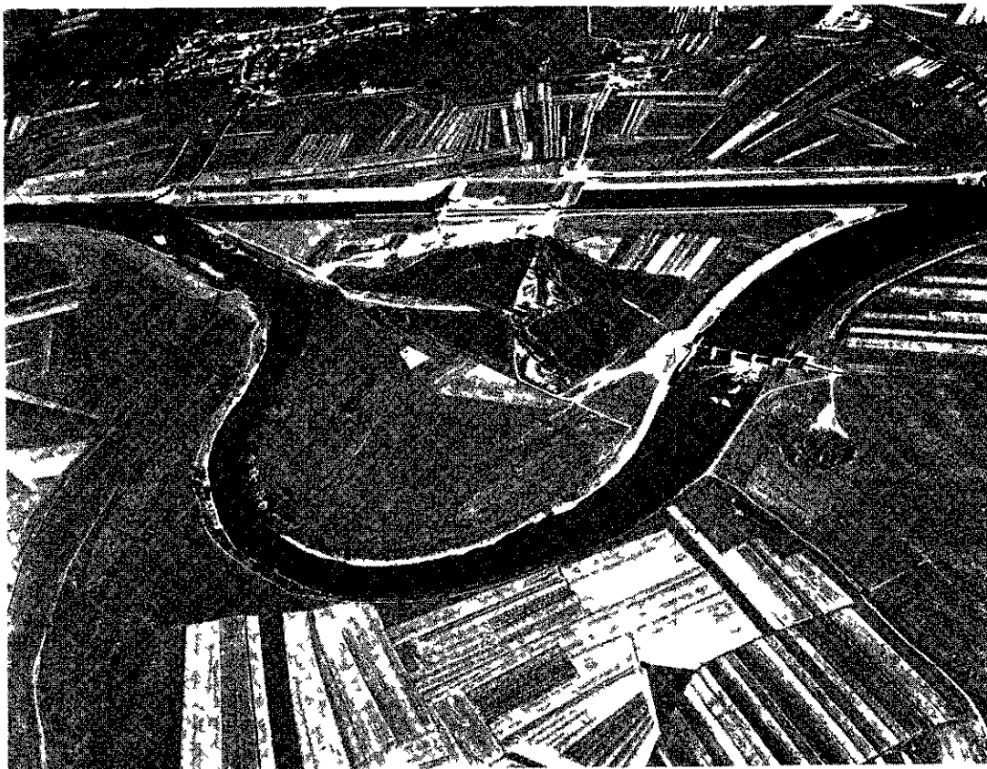
Barrage — Derivation et écluse de KœNIGSMACKER
