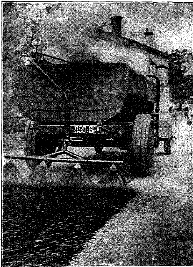
Répandage de GOUDRON-BITUME .
