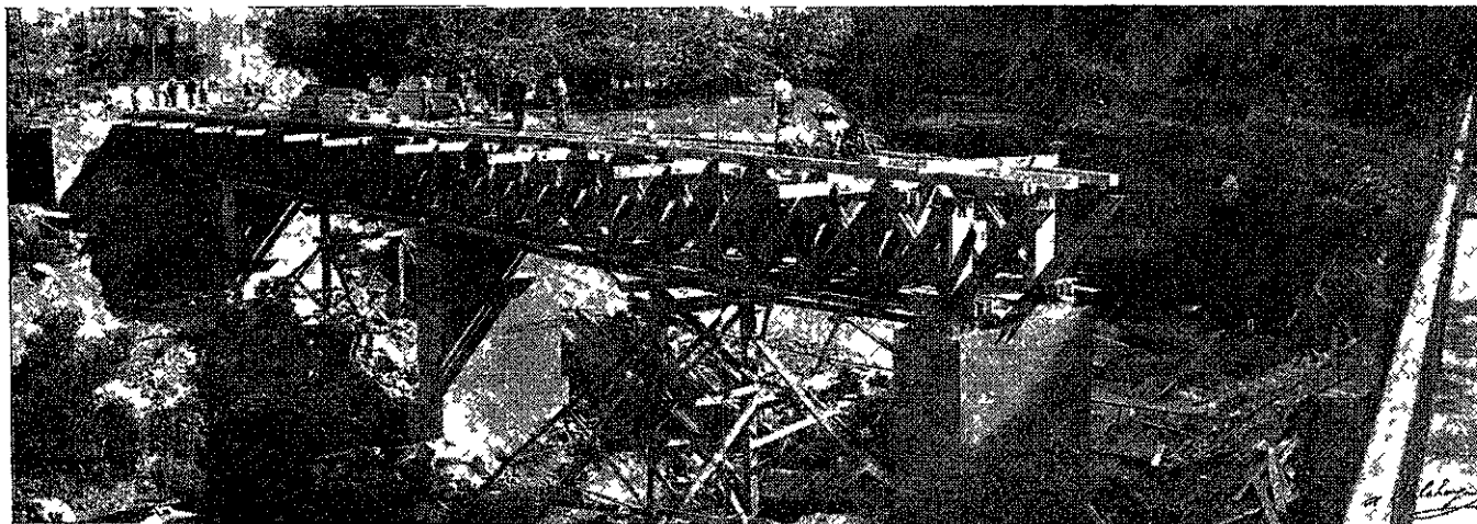
L'OUVRAGE EN COURS DE CONSTRUCTION
