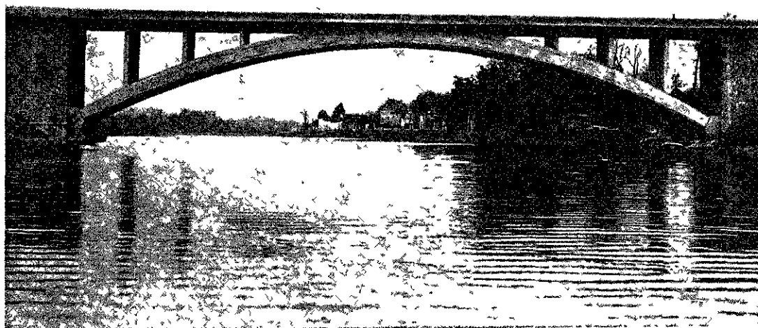
PONT DE LA JONNELIÈRE, SUR L'ERDRE (ligne de Nantes à Châteaubriant)
