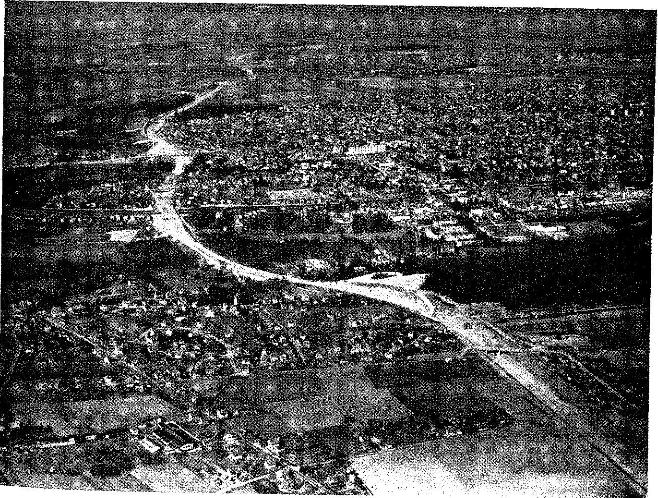
Vue aérienne de l'état actuel des travaux de l'autoroute en Seine-et-Oise dans la Vallée de l'Orge
