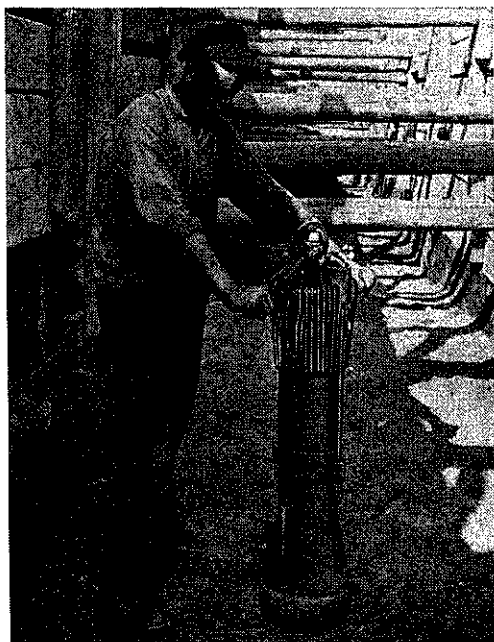
Pilonneuse DELMAG 100 kg Pilonnage de tranchée
