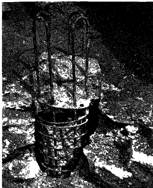
Photo 4. — Juillet 1955 Tête de pieu dégradée
