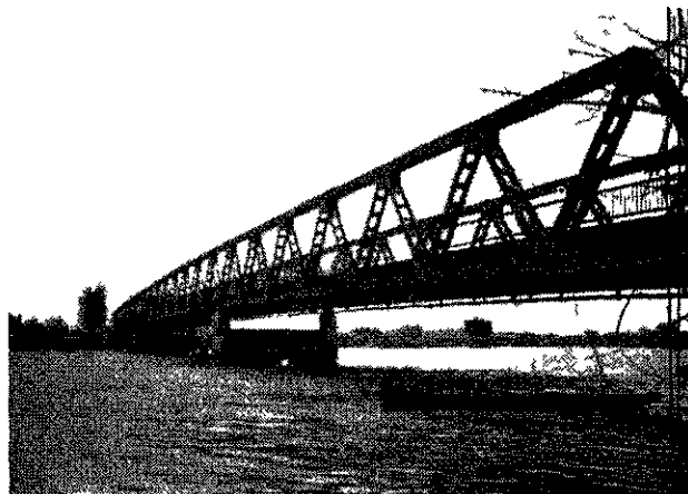
Photo 8. — Pont du Grand-Bras terminé
