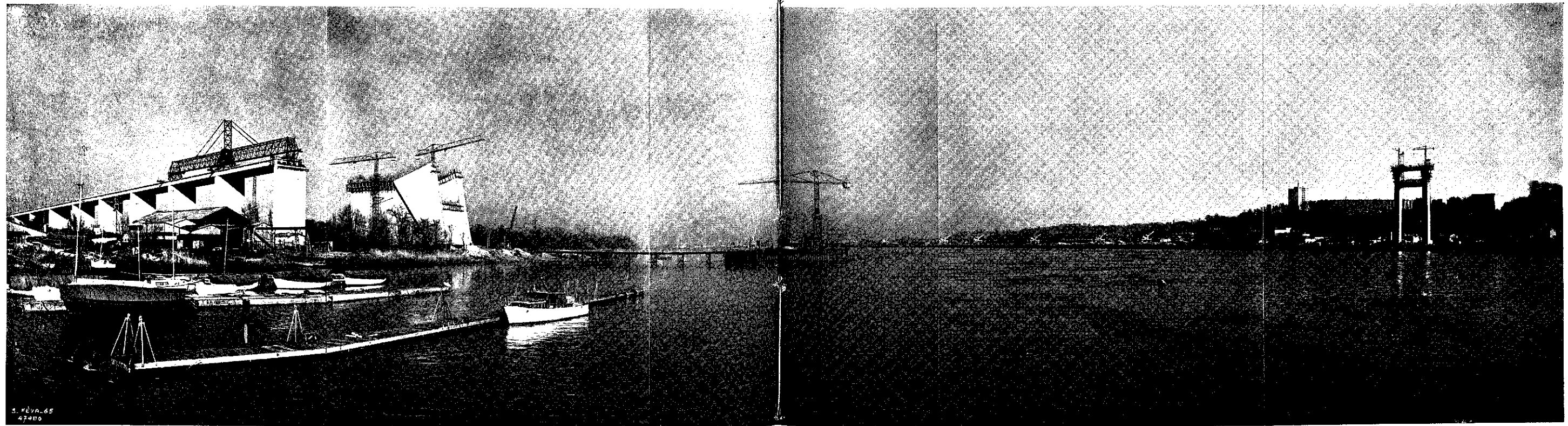
▼ Pont suspendu de Bacalan à Bordeaux
