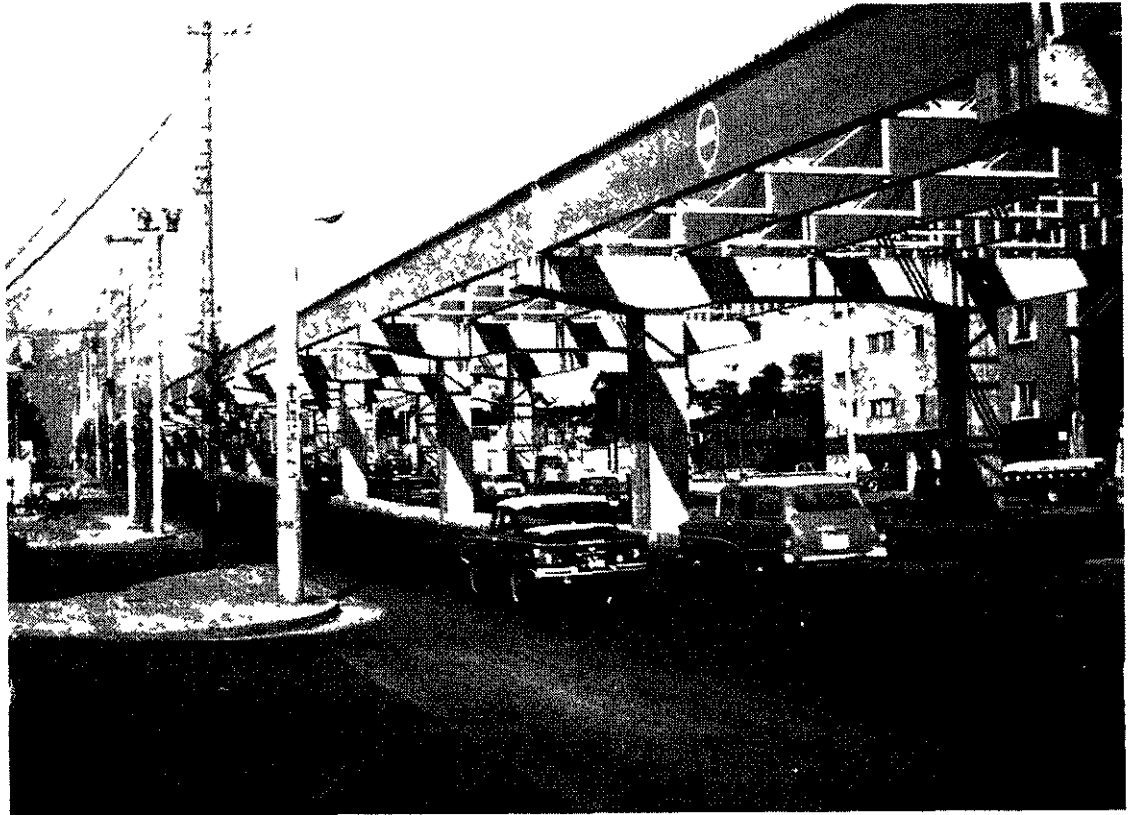
Fig. 5. — Construction du réseau : l'autoroute os 3 en construction dans le quartier des ambassades (OAYMA). Viaduc en travées indépendantes de faible portée (15 m) à poutres composites acier-béton (on voit nettement les connecteurs). L'autoroute sera en service à Noël. La photo date de juin 1965.
