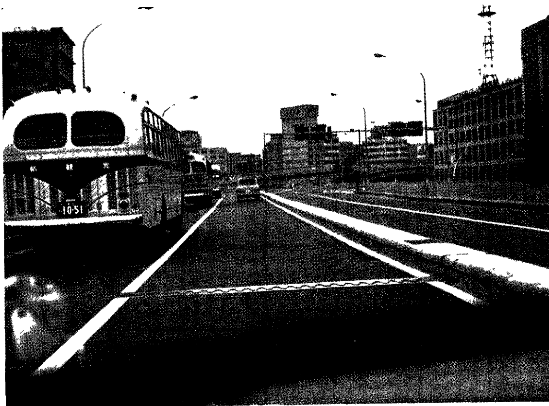
Fig. 2. — Impressions de conduite : sur l'autoroute n° 4 un peu avant le grand échangeur courbe sur la rivière EDO. Au JAPON on roule à gauche et la bande blanche continue est une matérialisation de voie soulignée mais franchissable (elle devient infranchissable si elle est jaune). Remarquer l'étroitesse des chaussées sans accotements notables et le petit terre-plein central surélevé en bute-roues.
