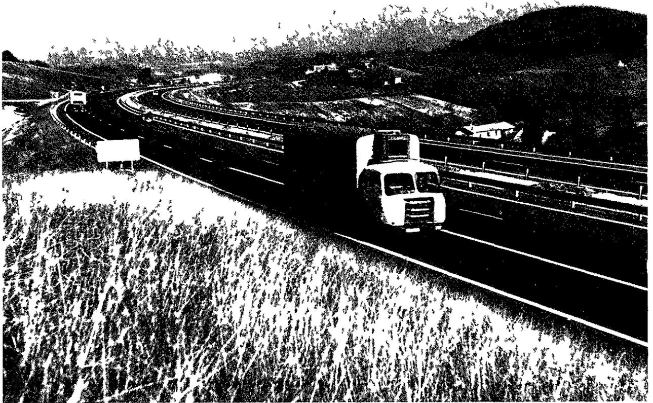
FIGURE 28 — Quelques-uns des 416 kilomètres ouverts à la circulation entre janvier 1963 et décembre 1965. On remarque une halte simple déjà fréquentée, le début d'une voie réservée aux poids lourds, un trafic déjà important (plus de 15 000 véhicules/j le mois de l'ouverture)
