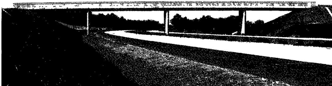
FIGURE 15. — Le plus répandu des ponts-types courants : le passage supérieur en dalle pleine continue précontrainte. Construit en série, dont la plus importante a atteint 38 ponts exécutés en 20 mois, cet ouvrage a déjà été livré en quatre ans à la circulation à plus de 200 exemplaires, faisant ainsi la preuve de sa vocation industrielle.
