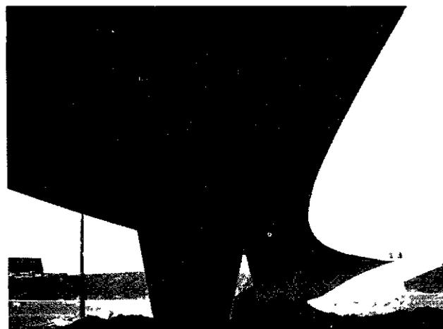
FIGURE 18. — Un autre pont spécial : pont en courbe de 800 m de rayon, à 4 travées de 25, 40, 40 et 25 mètres, en caisson précontraint. Ce type est également destiné à un emploi assez fréquent en zone urbaine.
