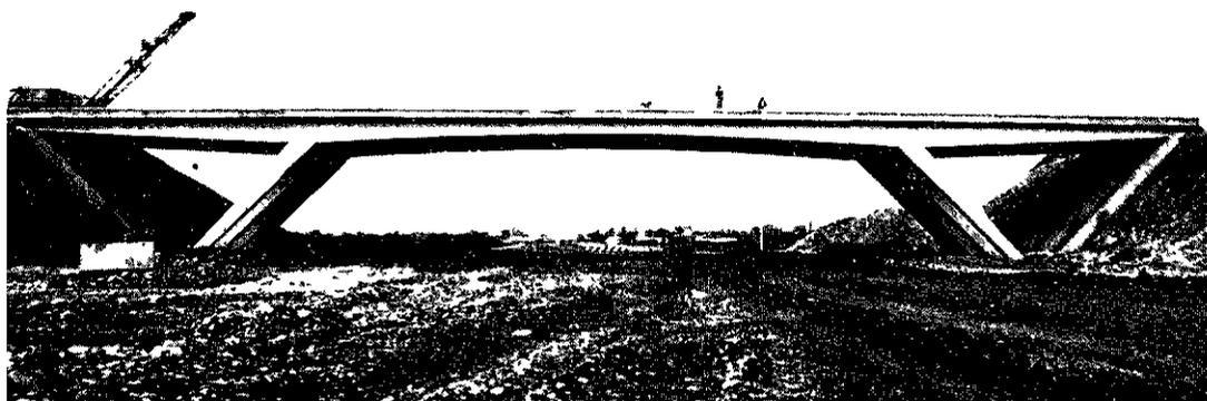
FIGURE 17. — Un pont spécial : pont en courbe de 75 m de rayon, à 3 travées de 22 m, en dalle précontrainte éléguée à larges encorbellements. Construit dans un échangeur, ce type d'ouvrage va se multiplier sur les autoroutes urbaines en géométrie difficile.
