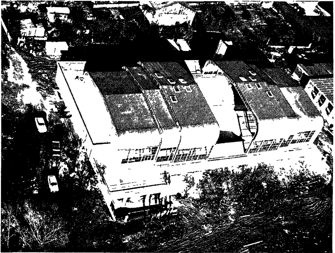
Piscine Municipale de Noyon Type Été-Hiver à Structure Mobile « Maglodome » (MacGregor-Comarain S.A.)
