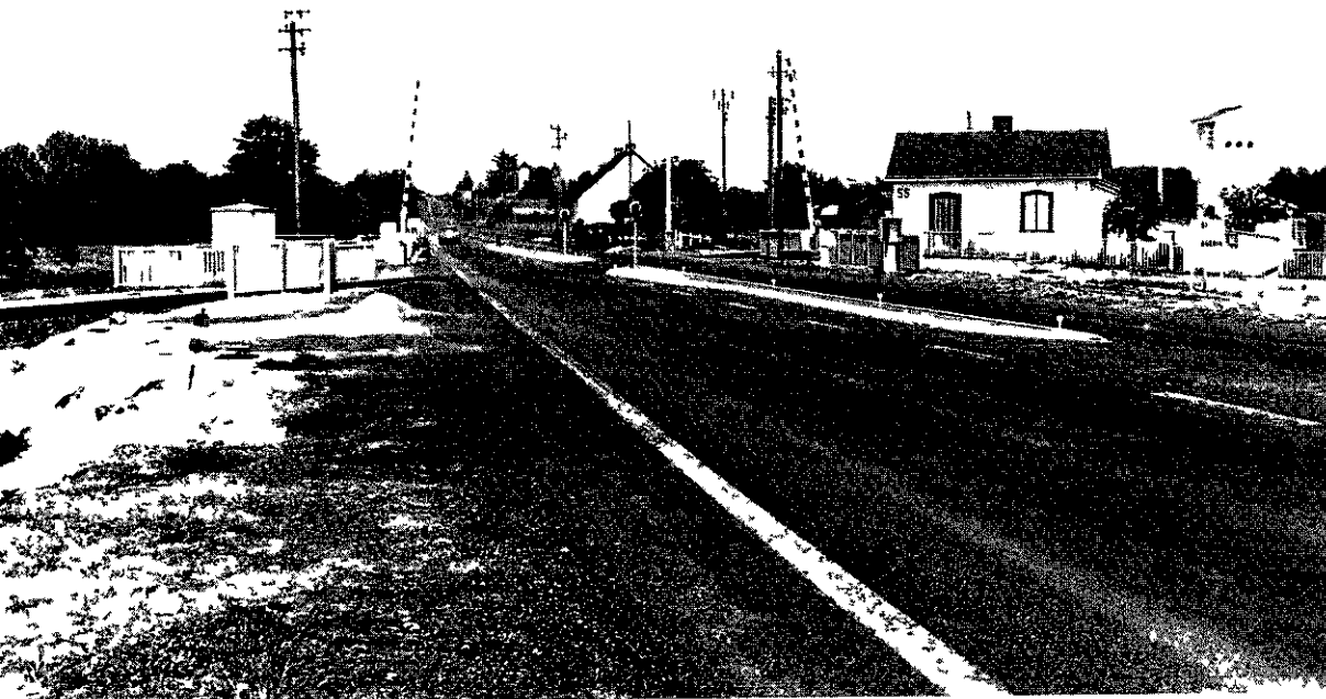
Passage a niveau a deux demi-barrieres automatiques
