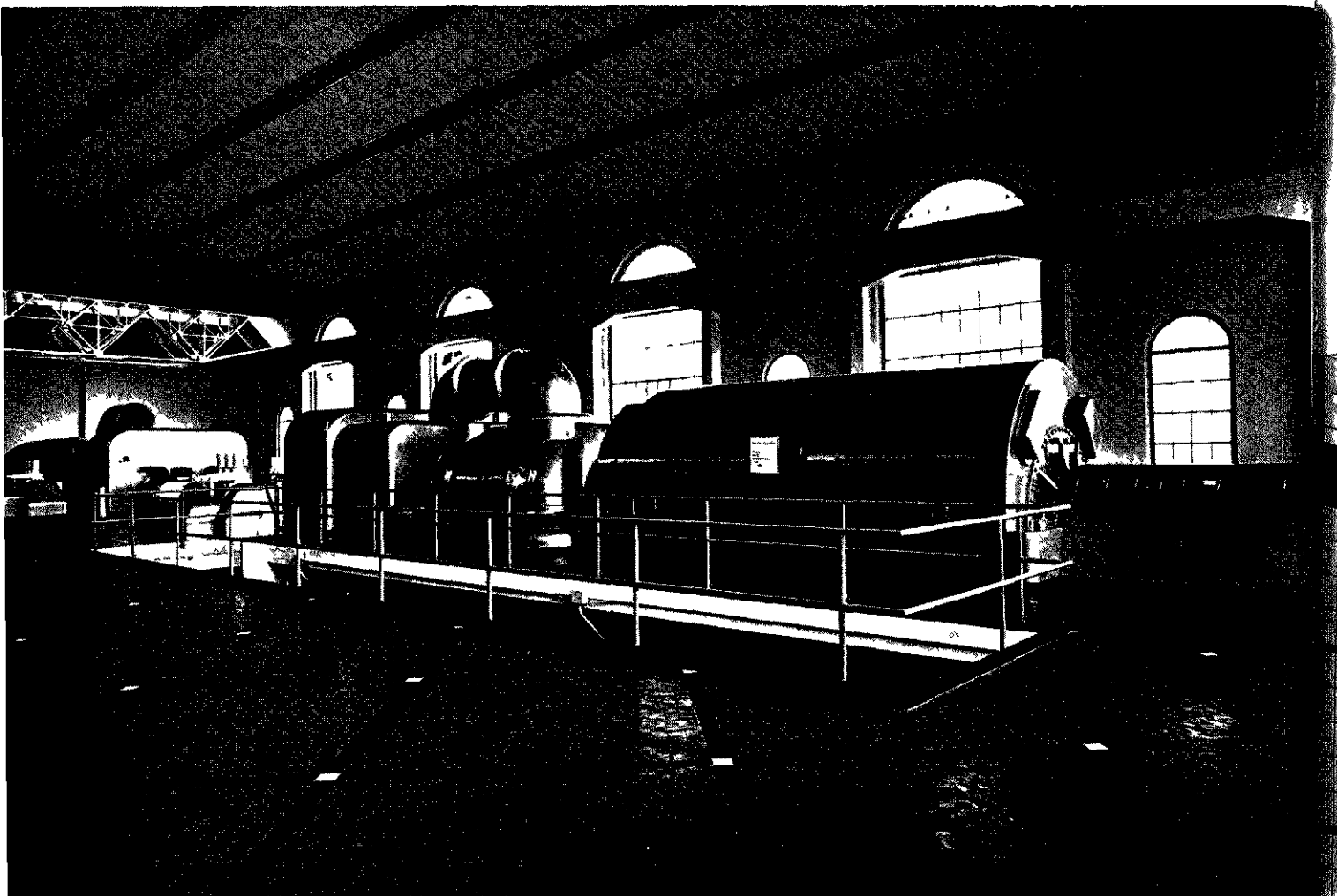
Salle des machines de la centrale thermoélectrique de Piacenza
