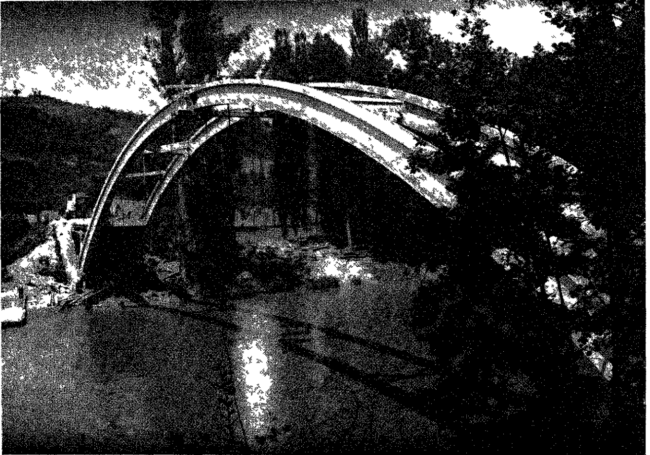
PONT DU PORT D'AGRES : LES ARCS APRÈS DÉCINTREMENT
