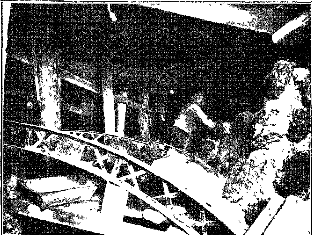
Galerie d'air recement dans la masse calcaire (2 e lot)
