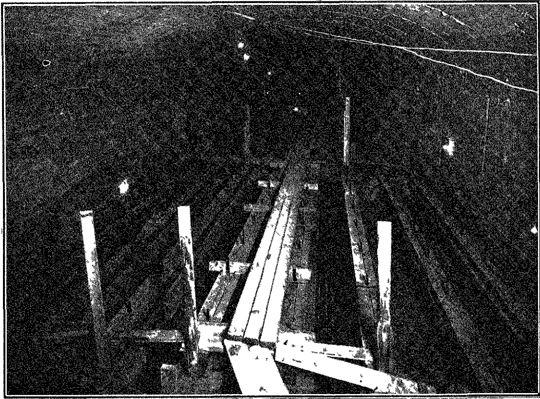
Porte de la Villette. — Passage souterrain pour voitures Traversée du Métropolitain ligne n° 7. — Branche de droite.
