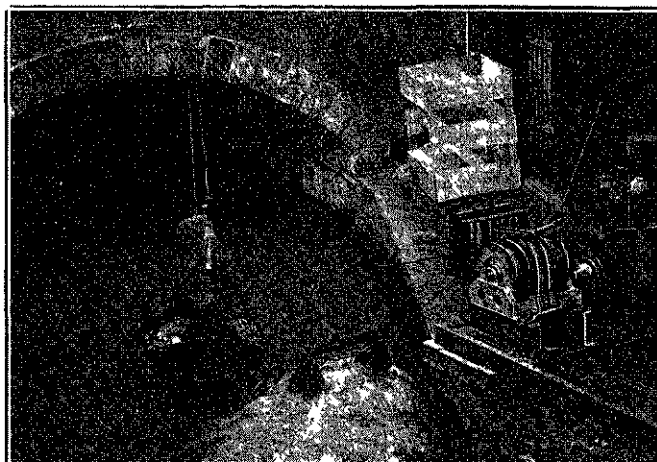
Ouvrage d'un canal en tunnel par SCRAPER PIC ABO alimentant une bonne
