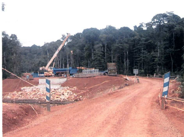
Vue du chantier de construction de la route France-Brésil.
