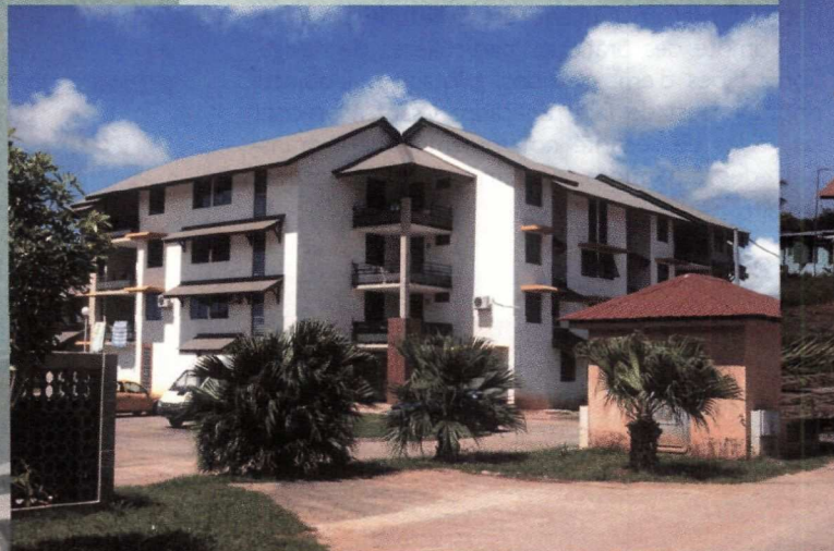
Novaparc Cayenne - 90 LLS (Architecte : Serge Karpoff)
