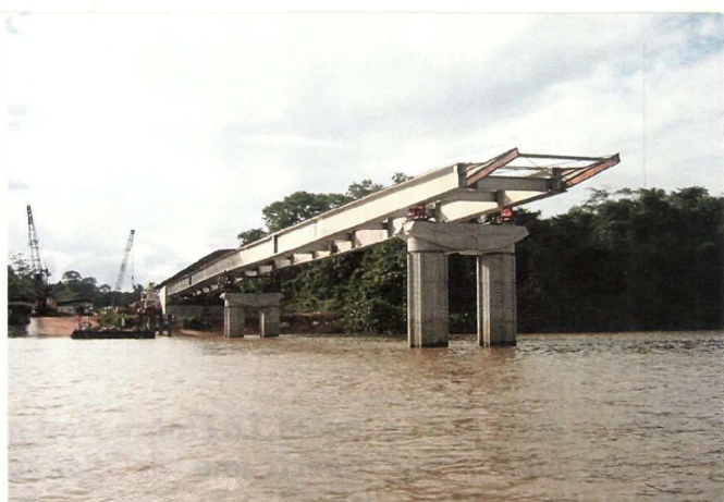
Le pont sur l'Approuague en cours de construction.
