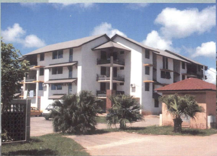
Novaparc Cayenne - 90 LLS (Architecte : Serge Karpoff)
