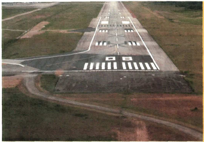
Le nouveau seuil de la piste de Cayenne Rochambeau.
