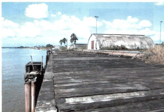
Le port de Saint-Laurent dont le quai sera réhabilité en 2003.
