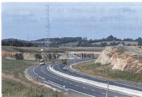
L'autoroute A28, traitement d'une zone rocheuse au sud d'Alençon.
