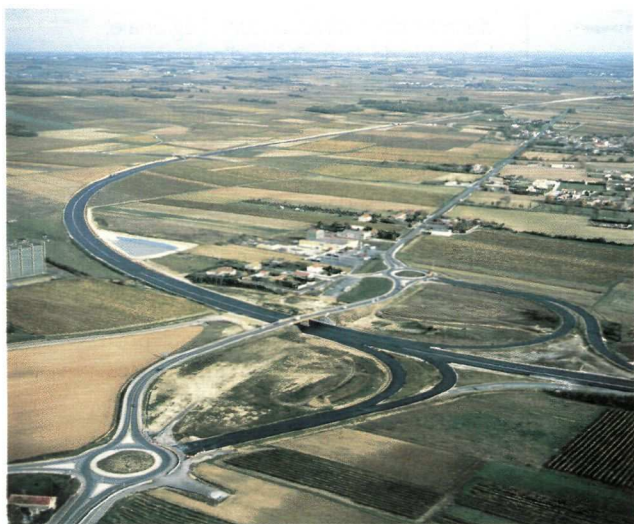
Aménagement de la RN 141 (Route Centre-Europe-Atlantique) Déviation de Bourras-Jamac. Au premier plan l'échangeur de Jamac Est.
