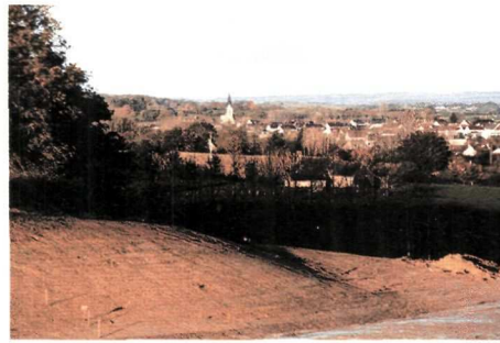
L'autoroute A28, création d'une fenêtre visuelle à Saint-Jean-d'Assé.
