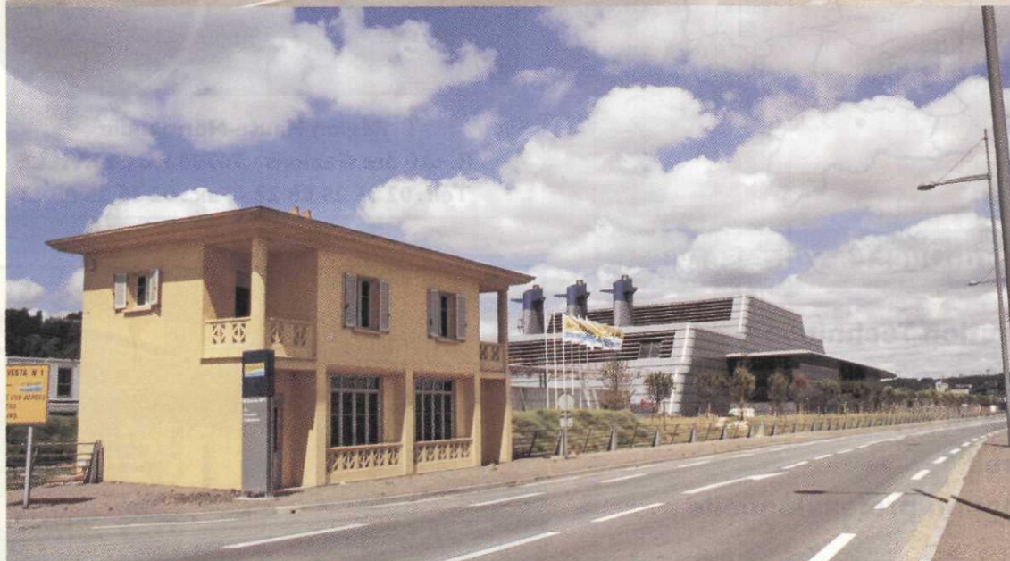
Le même site après intervention de l'EPBS : démolition des installations industrielles, traitement paysager et réhabilitation de la maison du gardien (dernier exemple de maison individuelle due à Auguste Perret). Le site accueille aujourd'hui l'usine de valorisation des déchets ménagers de l'agglomération rouennaise (1 MdF d'investissements)
