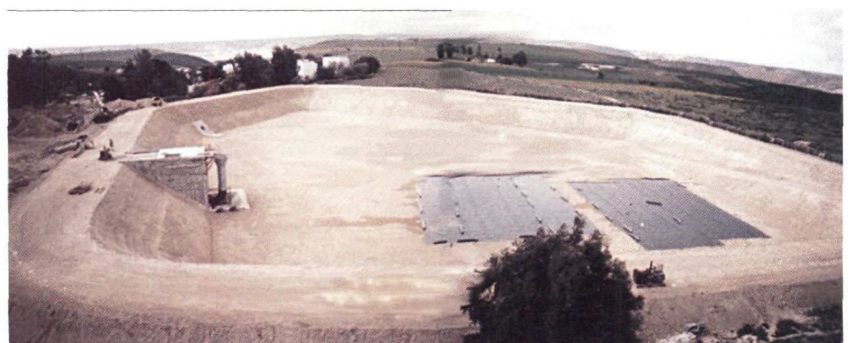
Bassin de stockage
