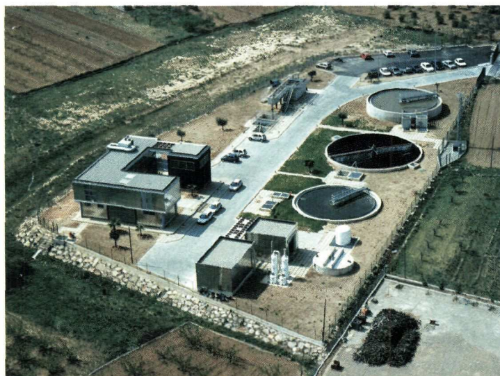
STEP de Chestre (lit bactérien) gérée par EGEVASA. Unique station de traitement des eaux usées de la Province de Valence certifiée ISO 14001.
