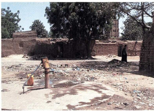
Figure 1 : Des forages n'offrant aucune garantie sanitaire (Niono - Mali).
