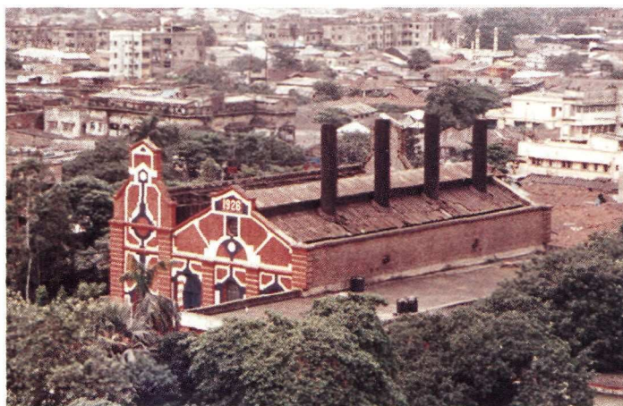
La station de pompage de Tallah.
