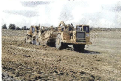
Terrassement à Henriville (57)
