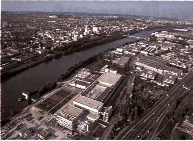
Usine de Colombes (Traitement des Eaux usées d'une capacité d'un million d'habitants) qui est un exemple d'insertion dans le site avec une technologie "zéro nuisance".
