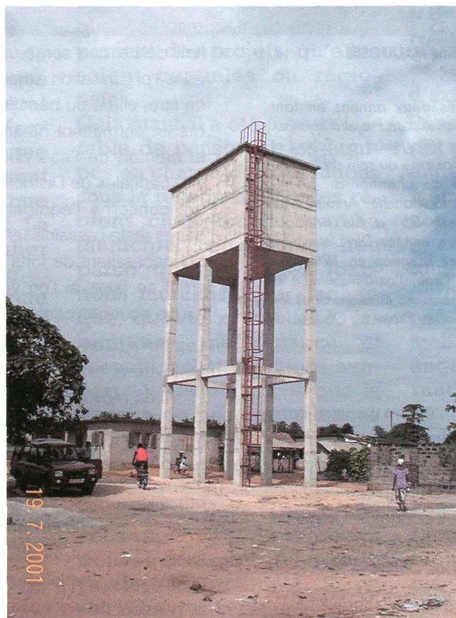
Un château d'eau en construction.
