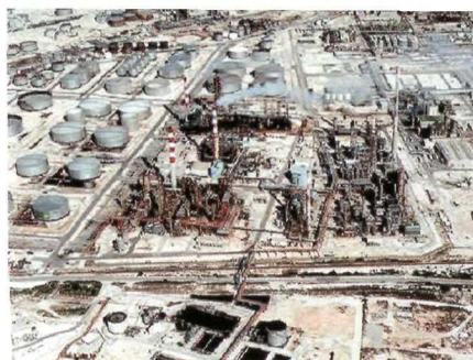
La raffinerie de BP-Lavéra, qui a confié à Vivendi Water la gestion de la station d'épuration, et le renforcement du potentiel épuratoire des ouvrages.
