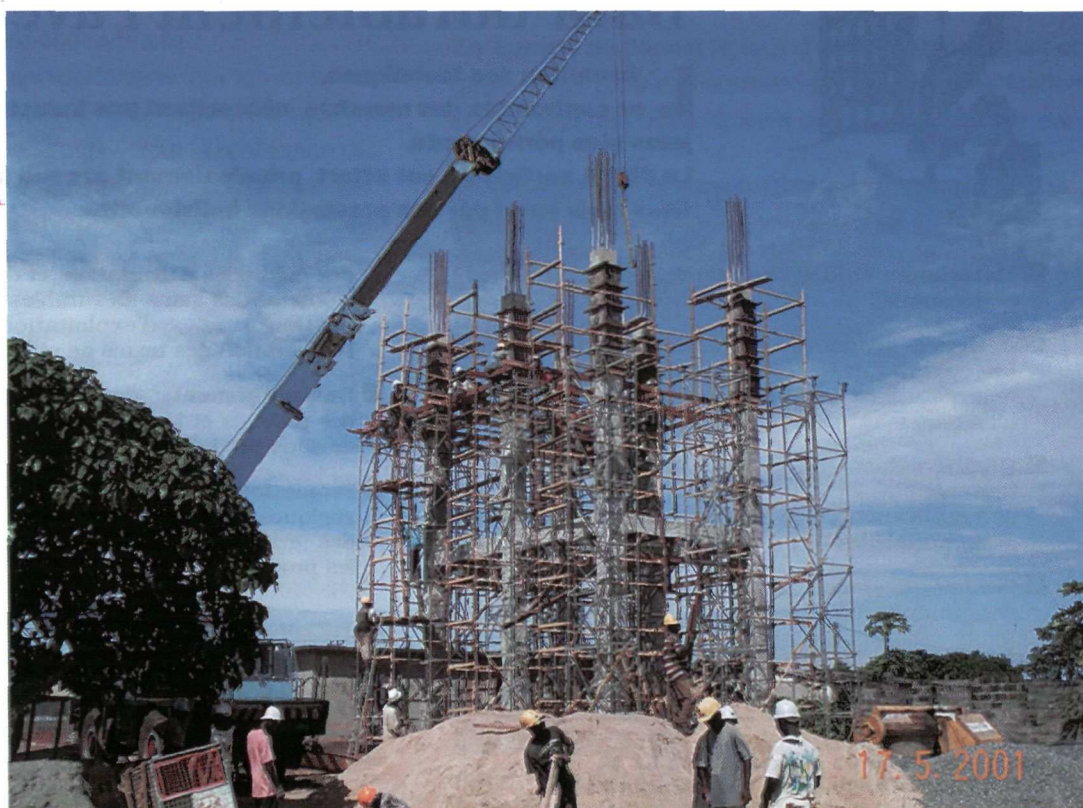
Le château d'eau 2 mois plus tôt.
