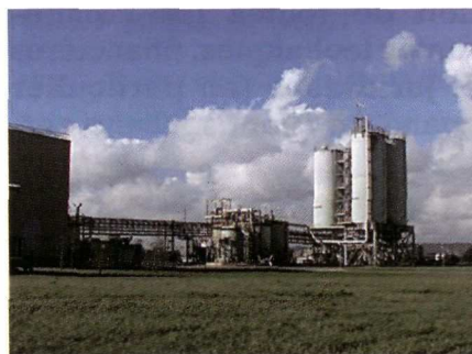
L'unité de neutralisation de Millennium Chemicals au Hode (76). Vivendi Water opère les installations et construit une nouvelle unité qui valorisera les coproduits.
