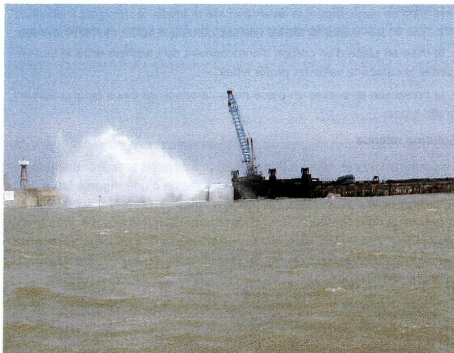
En 1976, une première tranche de pose d'encrochements en granit fut réalisée. Ces encrochements de 10 à 15 tonnes furent alors disposés à partir d'une cote moyenne le long du parement de + 6,00 CM ; ils forment un talus selon une pente approximative de 2/1.
