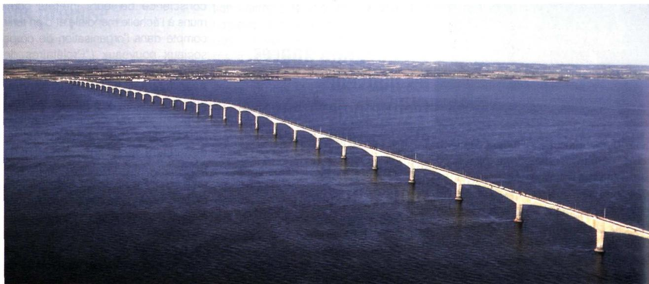
*Le Pont de la Confédération (Ile du Prince Edouard - Canada) GTM. Vue aérienne du pont de 13 km : 43 travées de 250 m et jusqu'à 60 m de hauteur au-dessus du niveau du détroit.*
