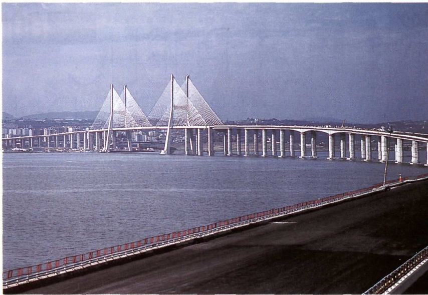
Pont Vasco de Gama à Lisbonne.
