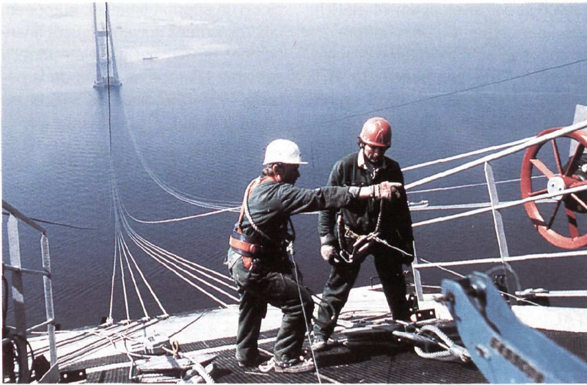
Pont du Storebaelt (Danemark).
