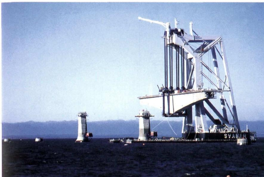
Pose d'un fléau de 8 000 tonnes par la barge Svanen relevée de 26 m et équipée d'un système de préhension baptisé "la pince à sucre".
