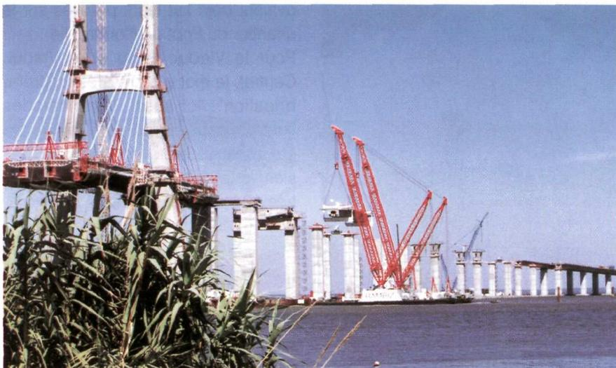
La pose d'une des poutres du Viaduc Central.
