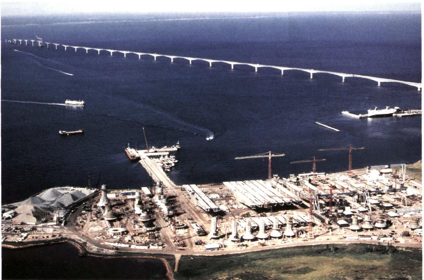
Vue d'ensemble du chantier avec, au premier plan, l'aire de préfabrication et ses 4 lignes de production.
