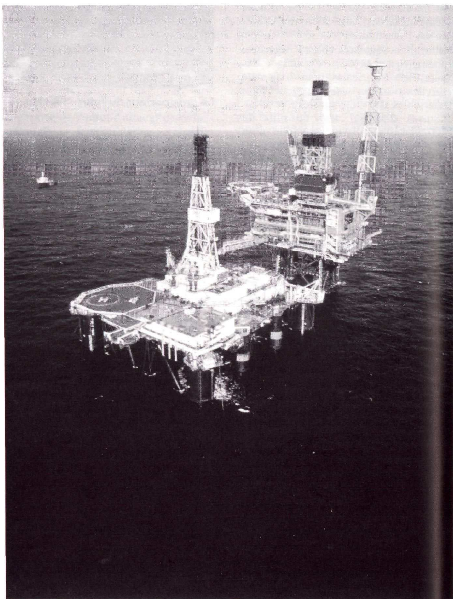
Protection anticorrosion par peintures : Plate-forme de Dunbar (UK).
