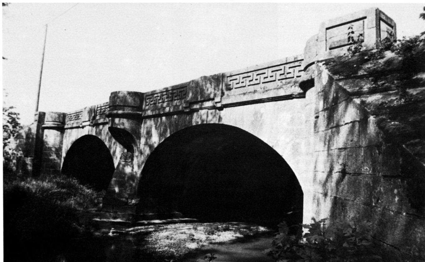
Le pont de pierre sur le ru de Baulches, près d'Auxerre, construit par Gauthy et Dumorey entre 1781 et 1786. Noter le caractère délibérément provocateur de la décoration, une caractéristique des ponts de la famille bourguignonne dans les années 1780.
