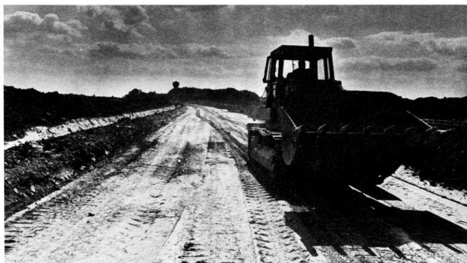
Disneyland, le premier coup de bulldozer.
