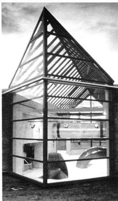
Usine de traitement d'eau potable du Pecq Minor. Salle d'ozonation.
