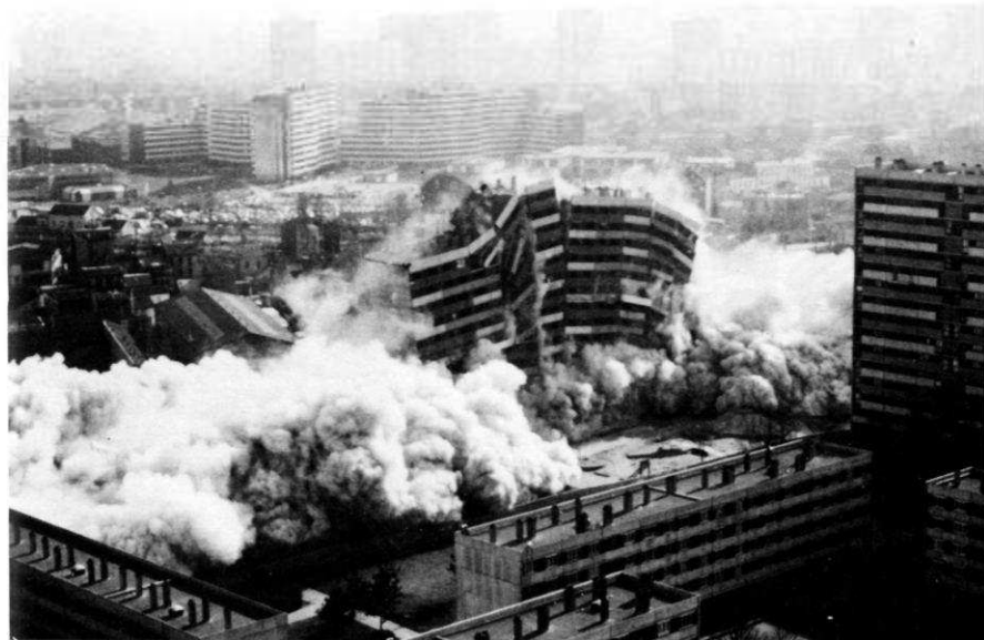
La Courneuve. Démolition d'un bâtiment RC + 15 étages en béton armé, 185 m de long, 11 m de large.
