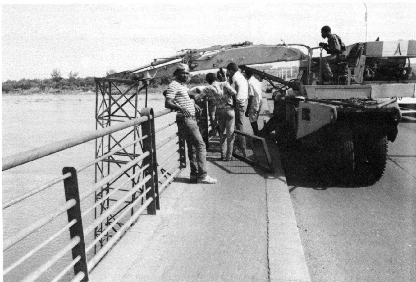
Passerelle de visite.
