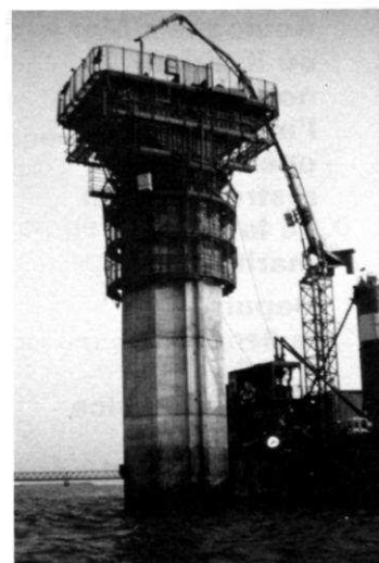
Chevêtre en cours de coulage.
