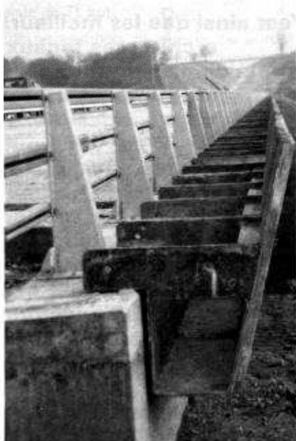
Corniche GRC Caniveau du Viaduc du Venant.
