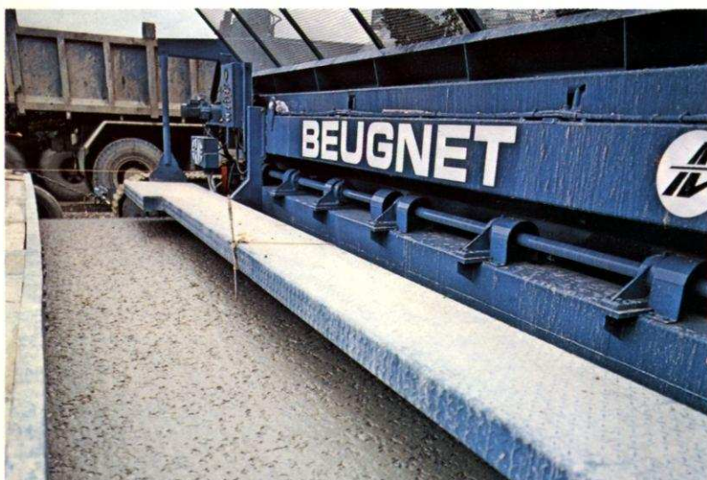
Aspect du béton clouté à la sortie de la machine C.M.I.-S.G.M.E.
