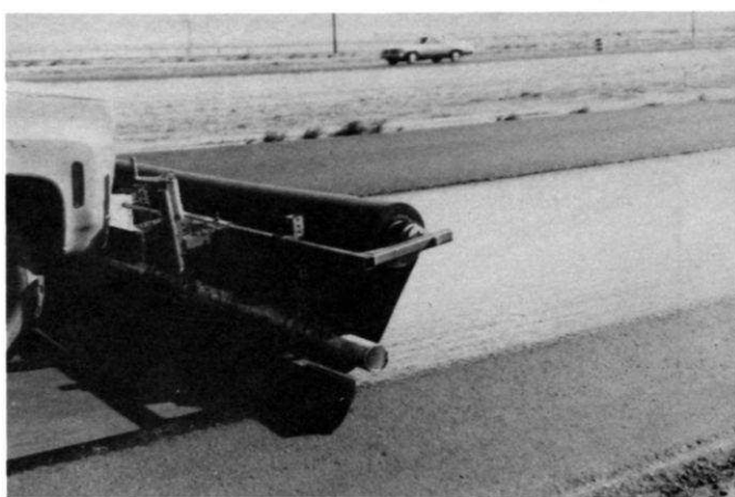
Mise en œuvre de l'AMOPAVE.
