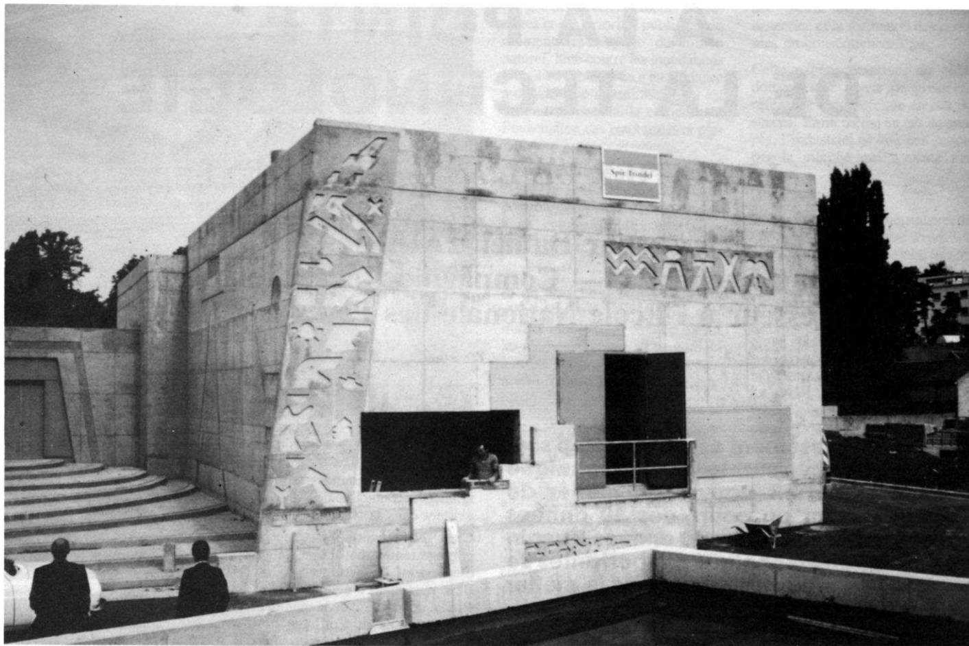
Station de relèvement de Crosne.
