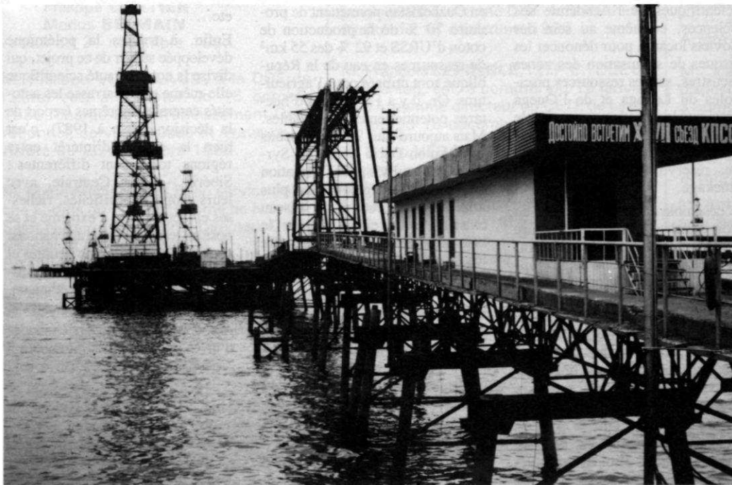
Installation off-shore à Bakou. Mer Caspienne.
