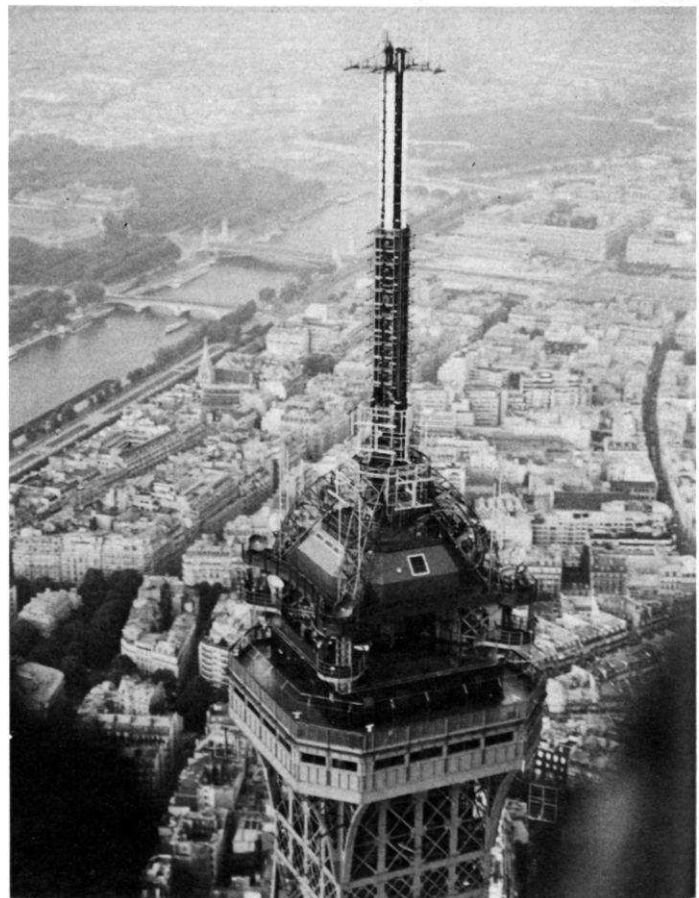
Restauration de la Tour Eiffel. Aménagement zone TDF 1982.
