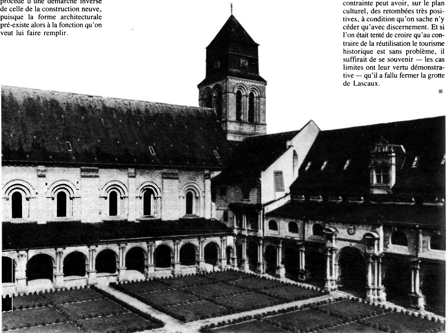
Abbaye de Fontevraud (Maine-et-Loire) le plus important chantier de restauration en France. Photo J. Feuillie/CNM HS/SPADEM.
