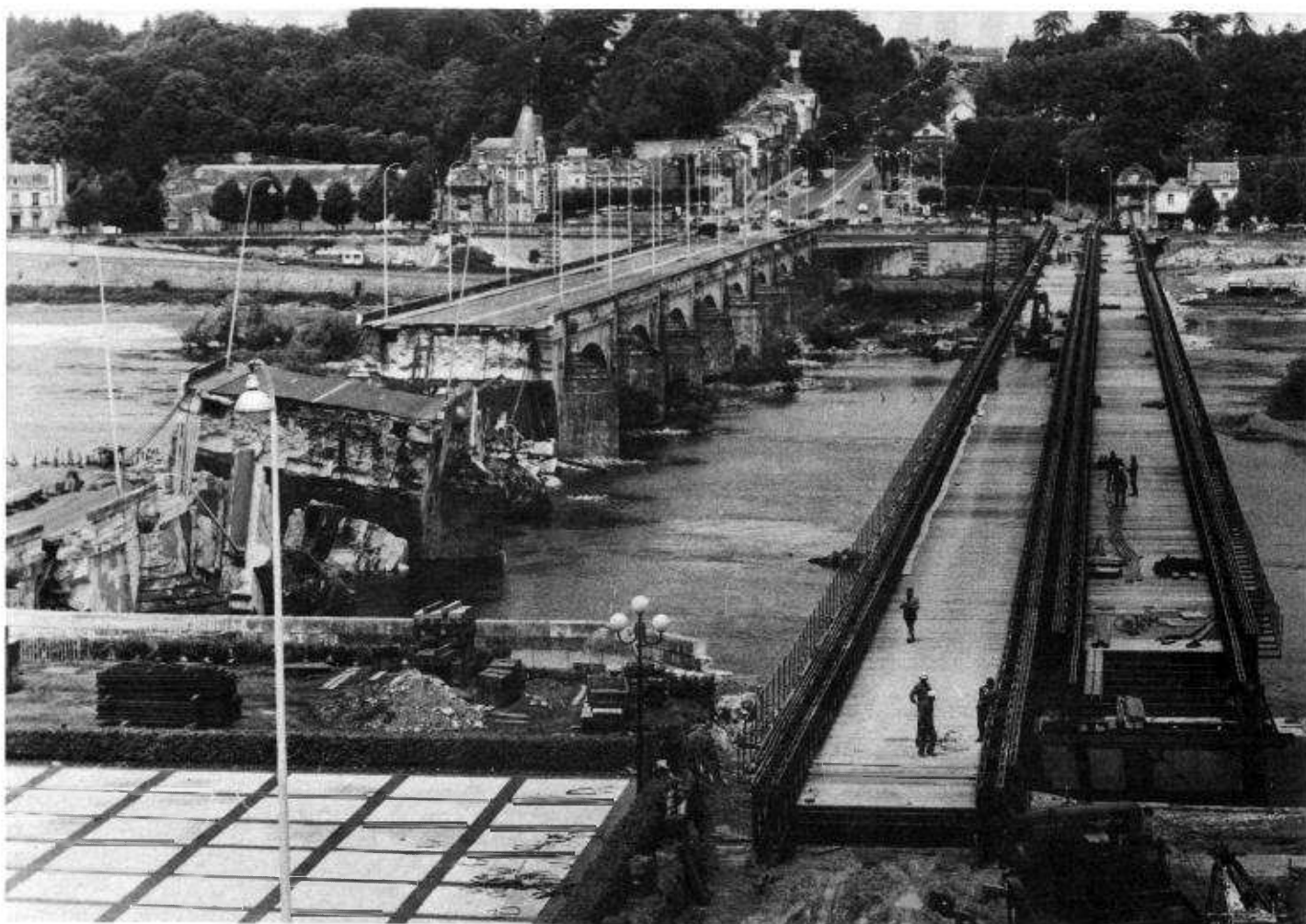
Le chantier en juin 78.
