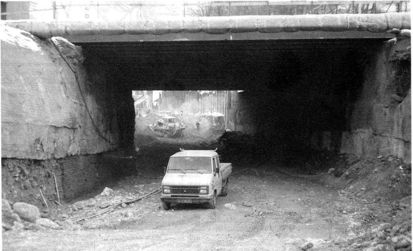
Trémie de Champoulet. Fouille blindée sous tablier provisoire.
