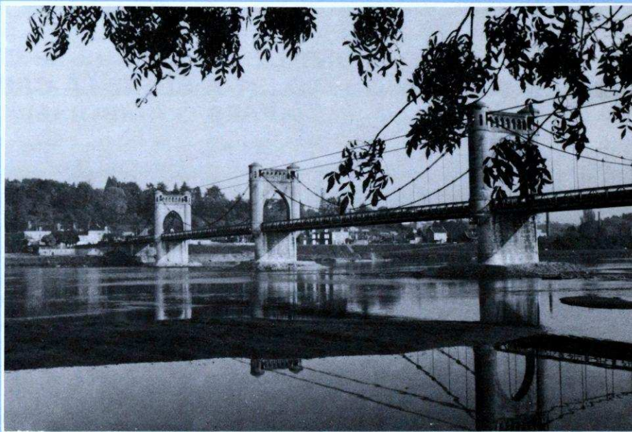
Pont de Langeais sur la Loire. Changement du cablage porteur en 1982-1983.
