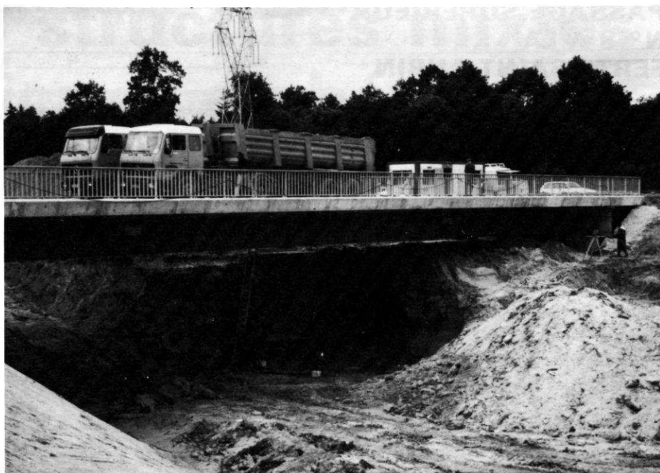
Essais du passage supérieur n° 8
