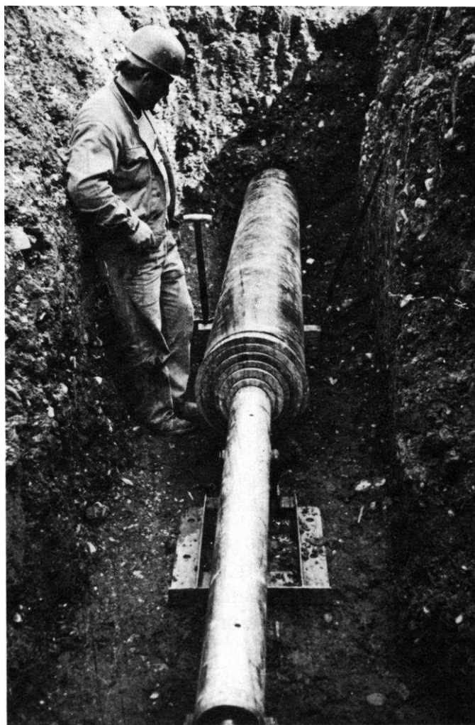
Fig. 5 : Pousse-tube Titan 145 mm lors d'un fonçage d'un tube acier de 400 mm sous route.
