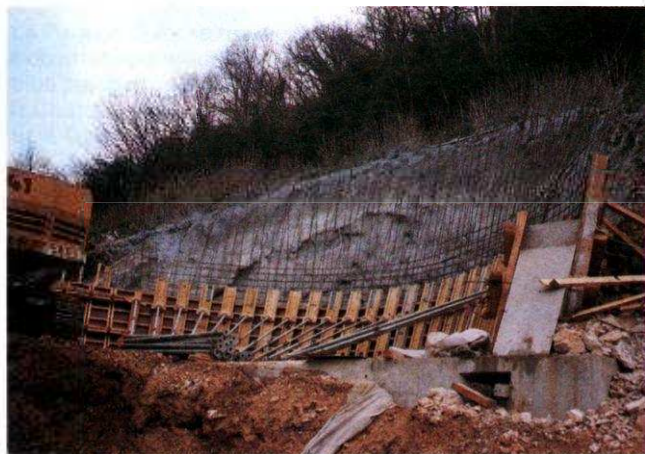
Fig. 16 - Viaduc des Neyrolles - Demi coque de soutènement pour protection d'un appui.
