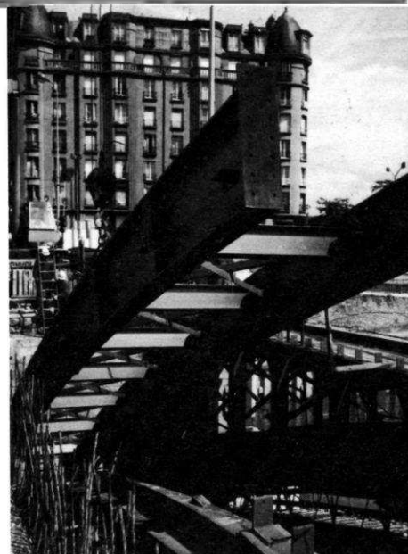
Mise en place de tronçon d'arcs neufs sur arcs provisoires.
