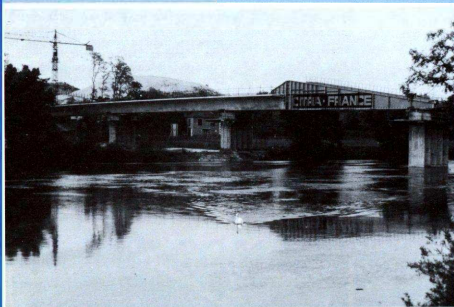
Poussage avec avant bac métallique.
