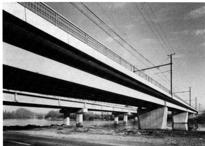
Pont d'Empalot (SNCF Toulouse)
