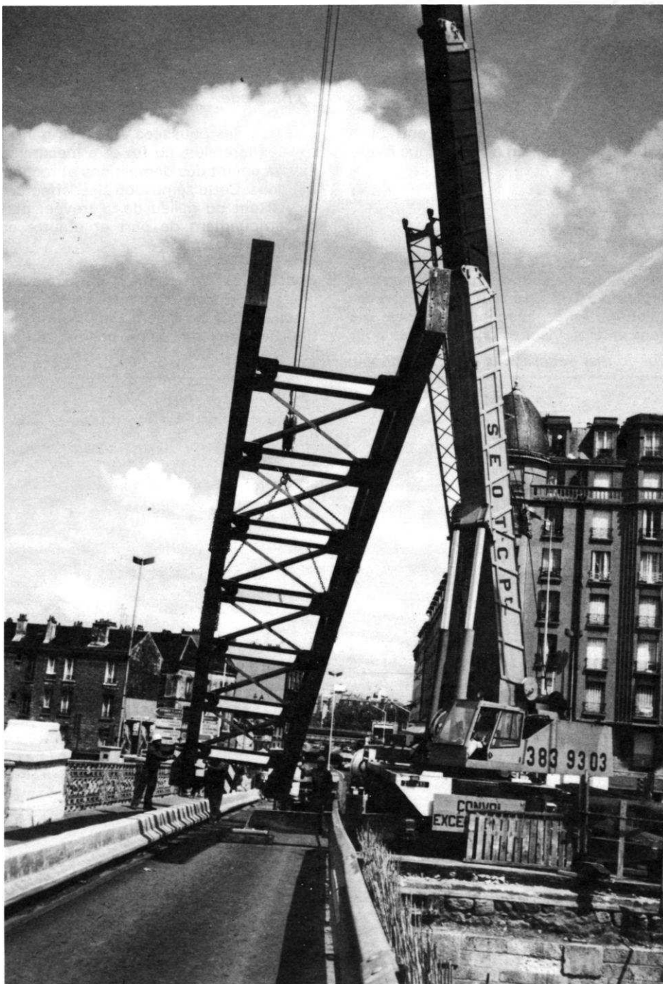
Mise en place de tronçon d'arcs neufs sur arcs provisoires.
