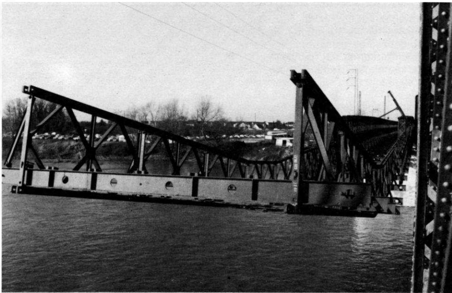
Pont Bailey en cours de lancement.
