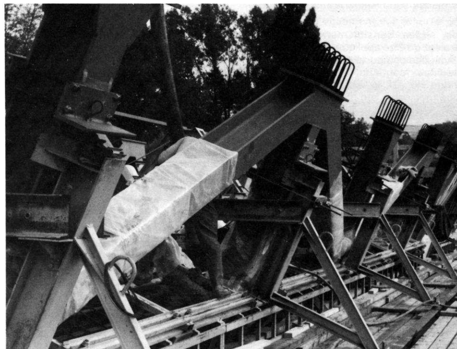
Pont d'Arbois – Mise en place des triangulations métalliques
