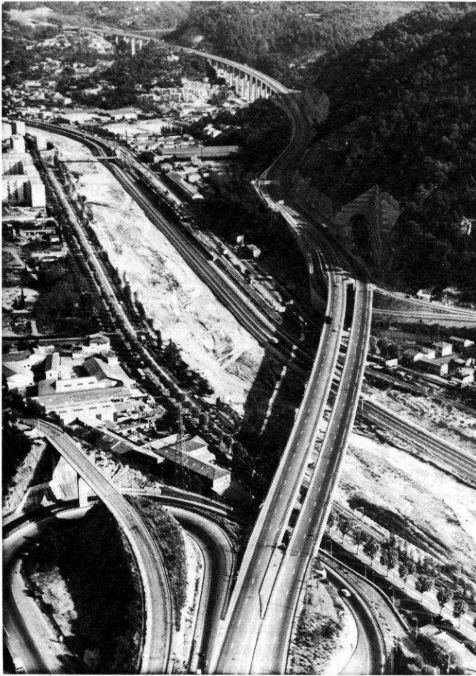
Tunnel du Paillon, réalisé pour la chaussée Sud et qui permettra l'amélioration des caractéristiques géométriques de la chaussée Nord.
