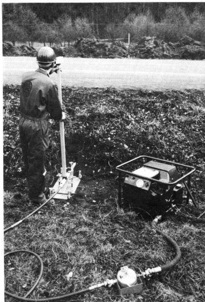
Fig. 3 : Mini Grundi 45 - unité de forage autonome avec son compresseur de 600 l/min.
