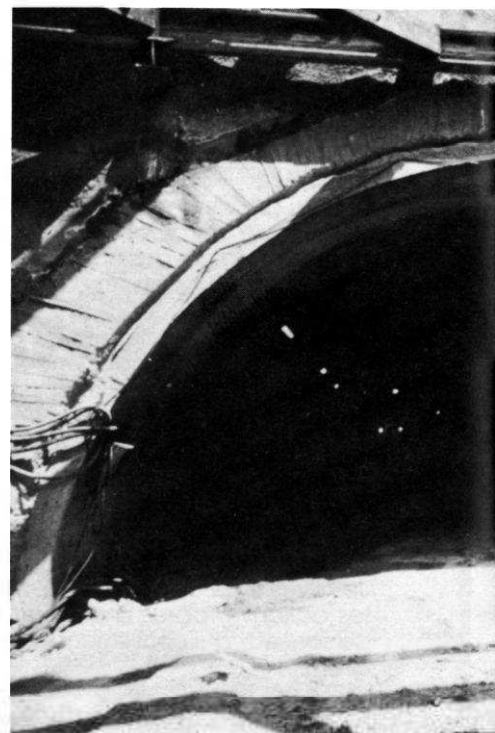
Tunnel de Fontenay.
