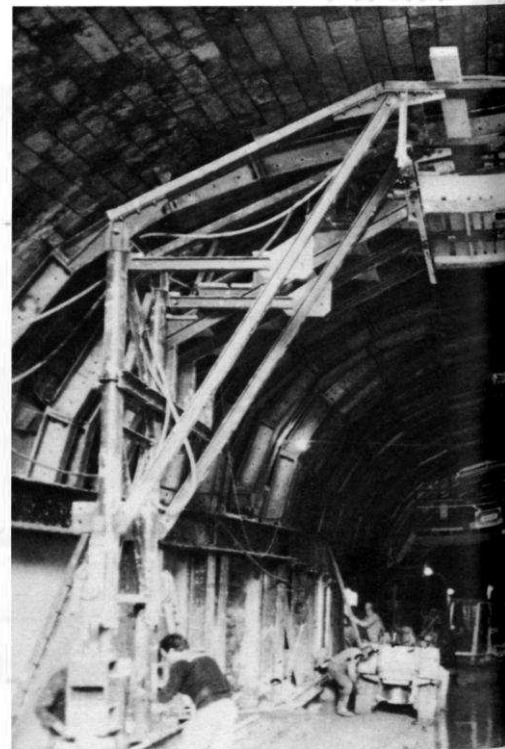
Mise sur cintre du tunnel de Boulaivilliers
