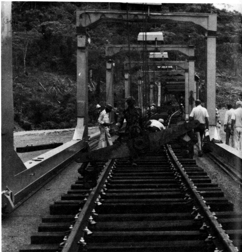
Transgabonais - Pose de voie Dinosaur - Panneau de 1,44 m.
