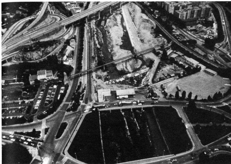
De l'aval vers l'amont : arrivée de la voie de berge à l'échangeur des Ponts Jumeaux.
