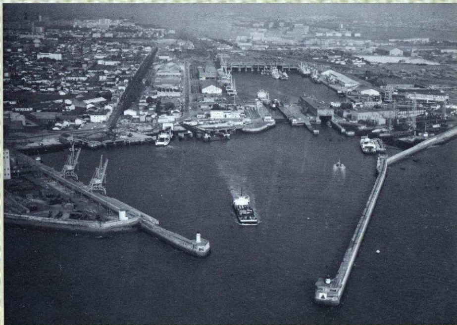
Vue d'ensemble de l'avant-port et du bassin à flot construits fin du XIX e siècle.
