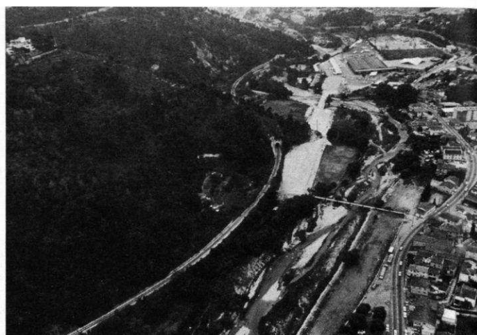
Vue prise vers l'aval au droit du CD 515. La plate-forme s'arrête actuellement à la passerelle pour piétons de Drap. Son prolongement vers l'amont empiètera dans le lit du Paillon. On aperçoit le méandre du torrent qui nécessite le double franchissement par les ouvrages n° 3 et 5.
