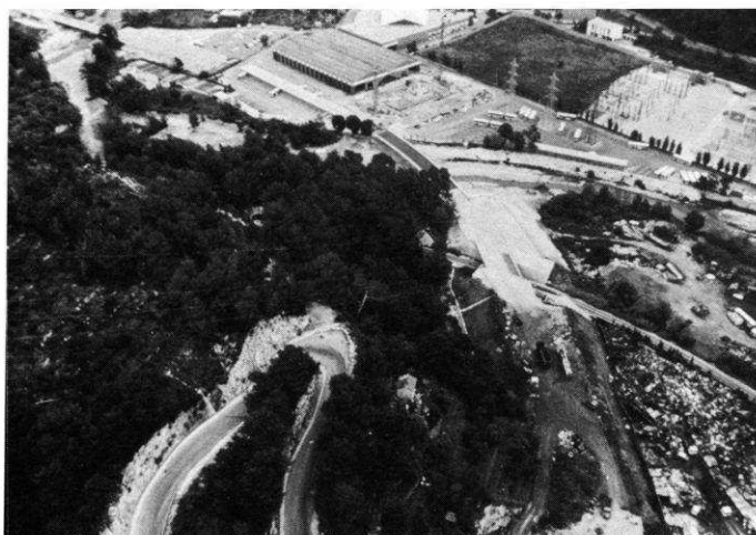
Vue prise vers l'amont. De bas en haut : pont sur le CD 1019, remblais en mâchefer, pont sur la voie ferrée, remblais, OA 3 franchissant le Paillon, emplacement du futur OA 3 bis, remblais, OA 5 sur le Paillon, remblais. La plate-forme a été mise en œuvre dans sa configuration définitive (2 fois 2 voies). Les ouvrages supportent seulement 2 voies et seront doublés à long terme.
