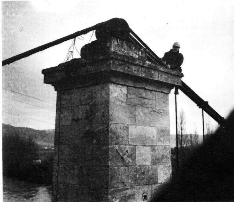
Fig. 2 : Inspection de câbles de ponts suspendus par bobine électromagnétique.
