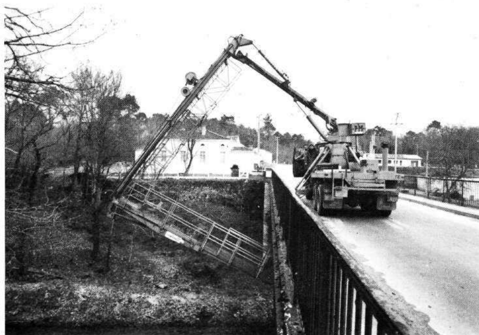
Fig. 4 : Passerelle d'inspection en service.
