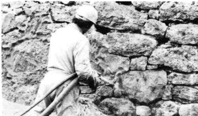
Jointoiment de maçonnerie de pierres sèches (250 kg de micro-béton par m 2 de parement a été introduit dans ce mur).
