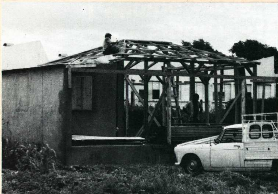
Construction de la case.
