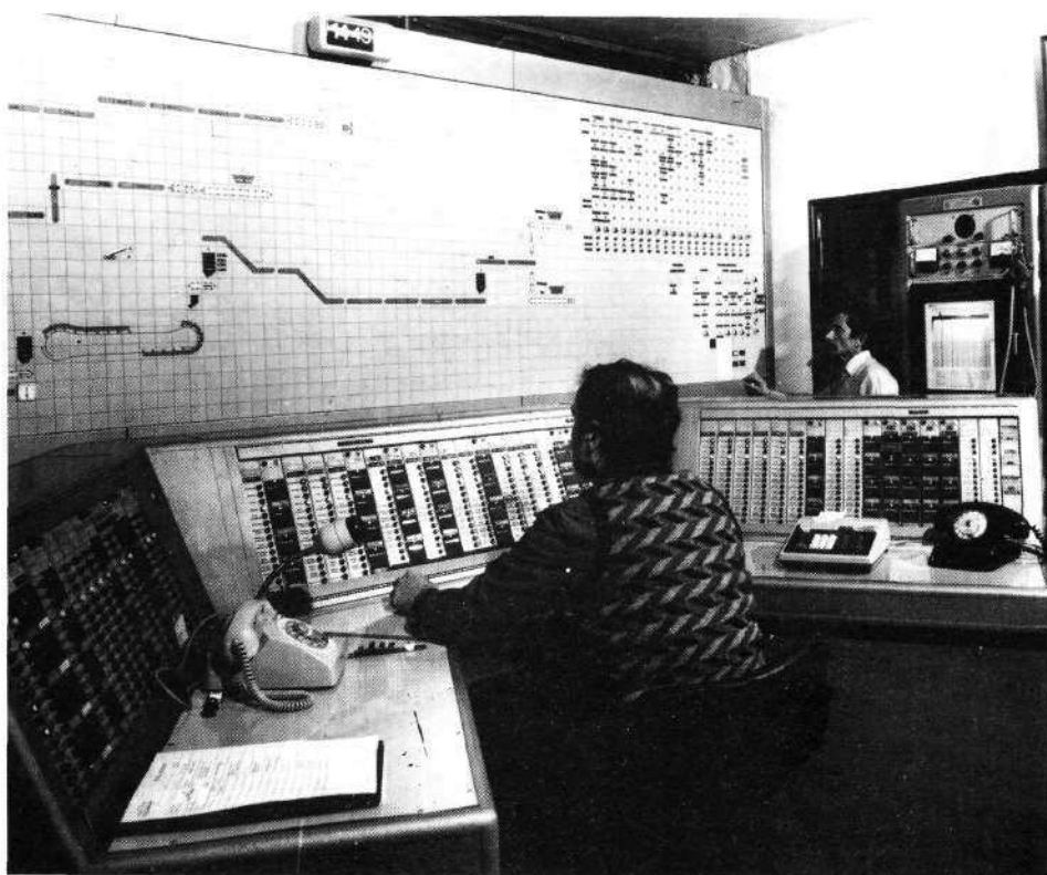
Contrôle de chantier par télévigile à Meyneuil (photo Mopy).
