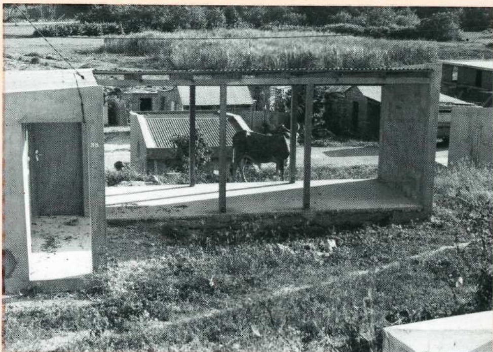
Structure d'accueil à la réception des travaux.
