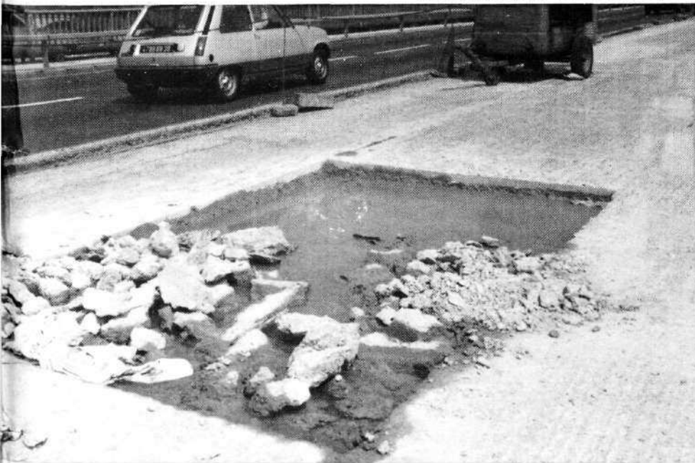
Réfection des plots de renformis dégradés.
