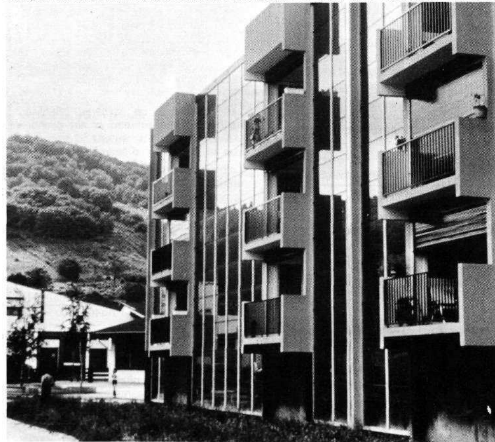
Réalisation expérimentale du Plan Construction à Bourgoin-Jallieu en Isère. (Un immeuble laboratoire pour mieux connaître le fonctionnement des systèmes solaires). Arch. AUDRAIN.
