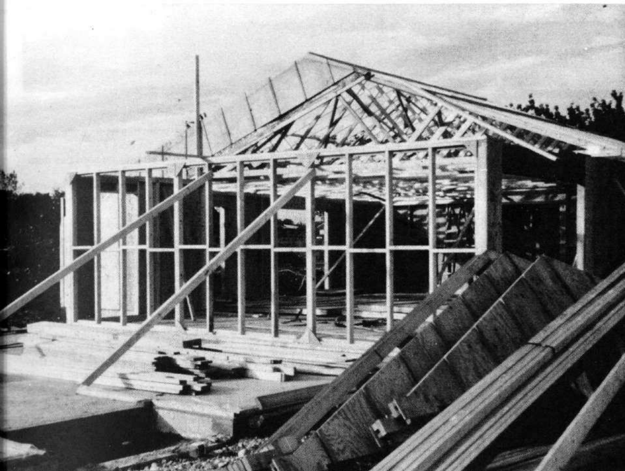
Rousillon : structure porteuse des maisons SCIC.
