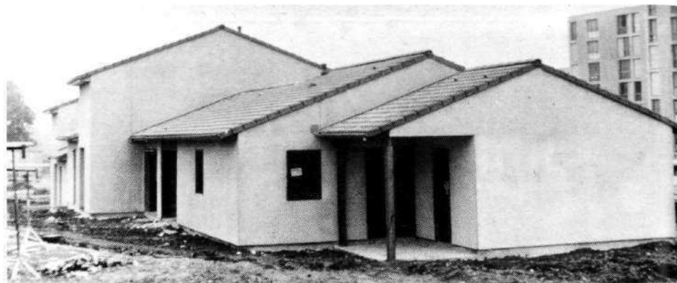
Maisons SCIC à Roussillon en cours de chantier.
