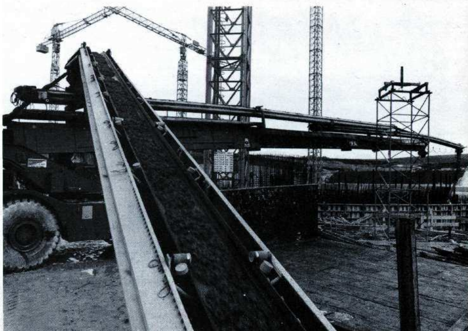
Centrale de Paluel - Mise en place de béton par une grue de distribution par tapis.
