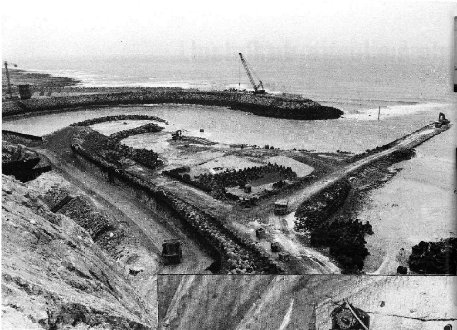
Centrale de Paluel - Creusement du chenal et construction des digues.
