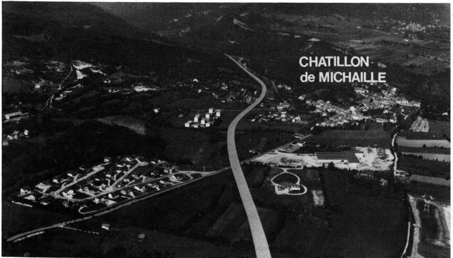
Passage de Chatillon. De nombreuses protections ont dû être prévues.
