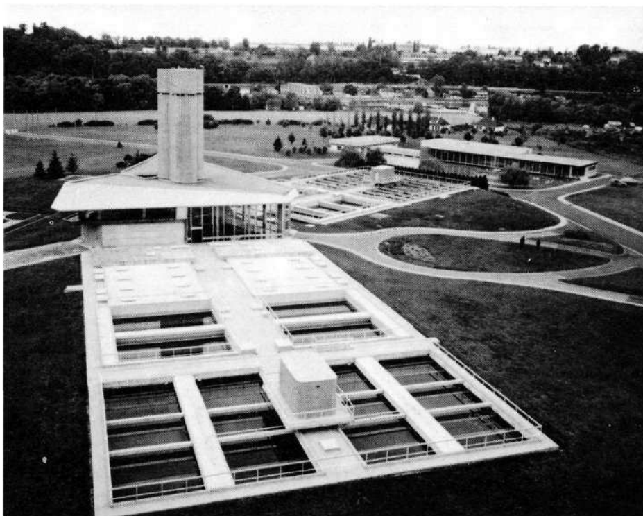
Usine de traitement des eaux de Morsang/Seine (150 000 m 3 /jour).
