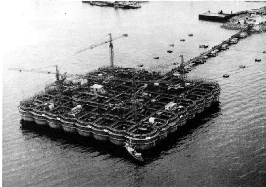
Fig. 6 - pendant la construction du caisson en coffrages glissants, la plate-forme, qui s'enfonce progressivement, est reliée à la terre par une passerelle flottante ; celle-ci supporte les canalisations qui transportent le béton pompé jusqu'au sommet des murs.
