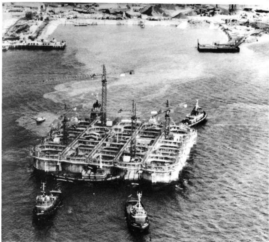
Fig. 5 - un premier remorquage de quelques centaines de mètres seulement, amène l'ébauche de la plate-forme jusqu'à un site profond et abrité, où l'on pourra construire l'ensemble de la structure en béton.
