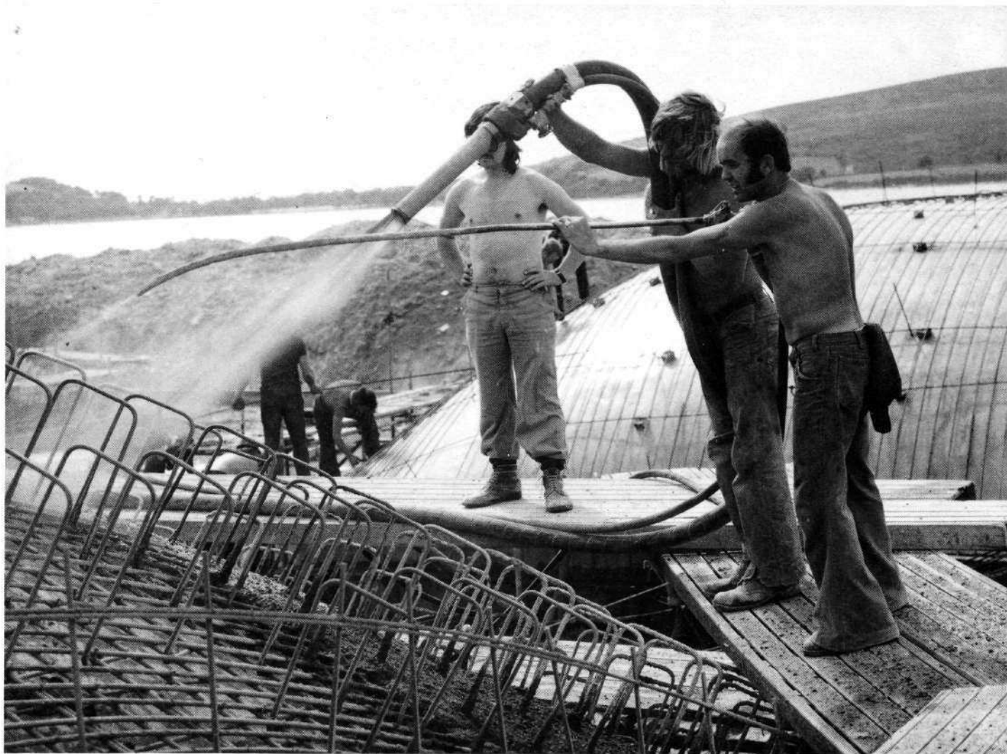
Fig. 7 - les toits des cellules du caisson sont coulés sur des coques en béton préfabriquées constituées par du béton projeté sur un quadrillage d'armatures.
