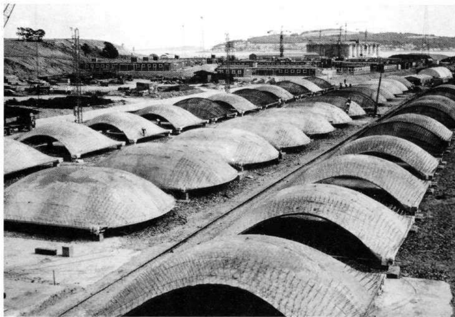
Fig. 8 - Chaque coque pourrait former la couverture d'une maison individuelle confortable : ses dimensions en plan sont environ 12 x 12 m
