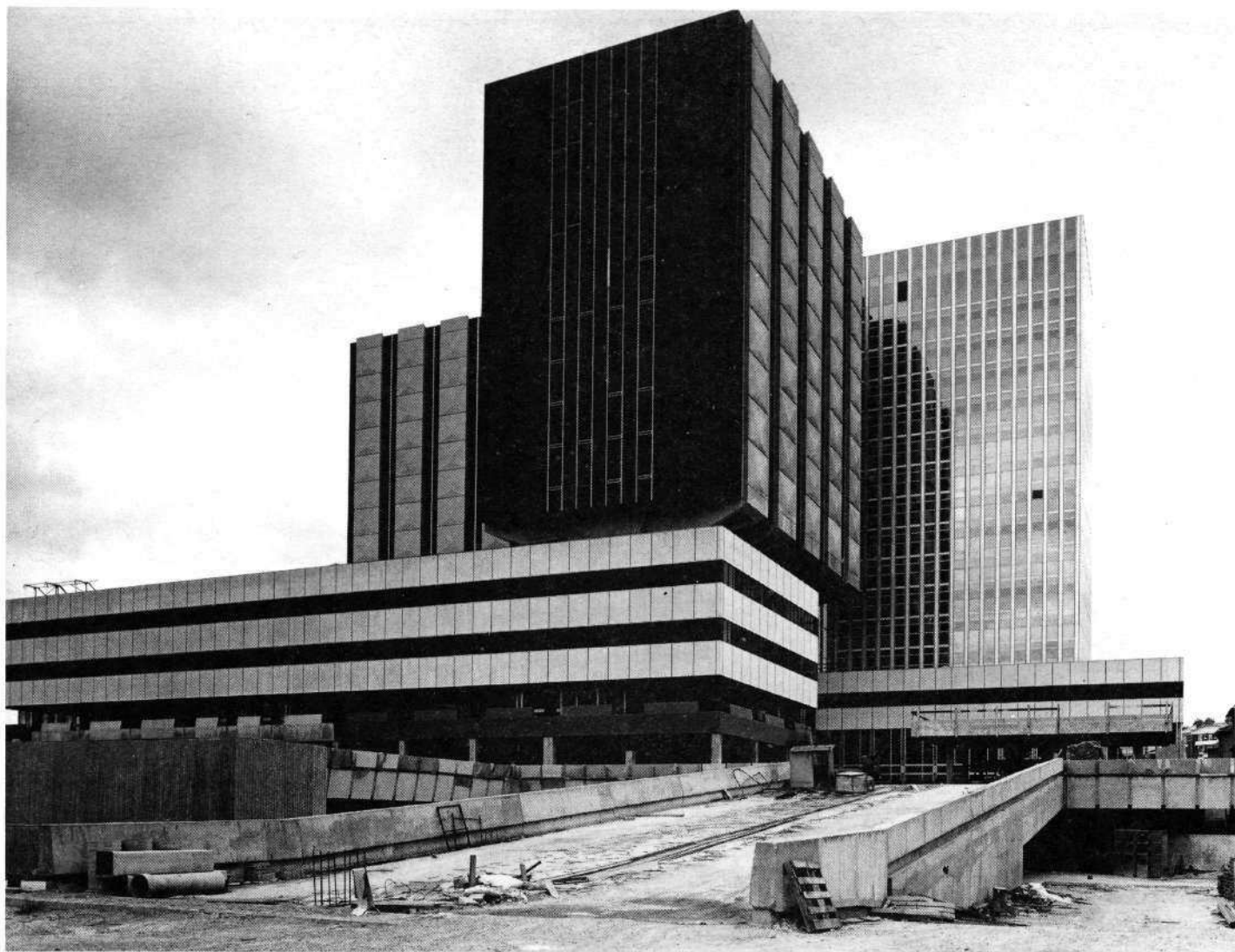
CHU Bichât façade ouest. Juin 1979. Photo Assistance publique.
