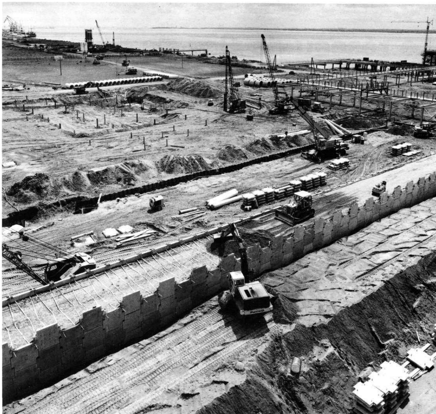
Construction de la cuvette de rétention d'un des réservoirs. Photo Y. BLOND - Nantes.
