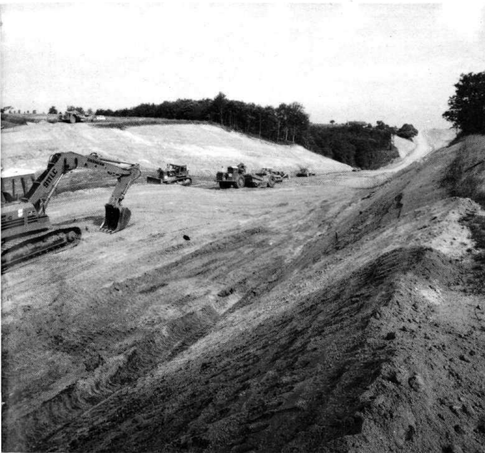
Fig. 6 Chantier de terrassement par la ligne Paris Sud-Est.
