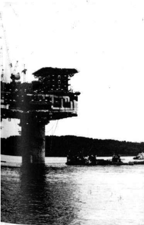
Fig. 18 - les remorqueurs reprennent la plate-forme en charge avec cette fois-ci un tirant d'eau de 135 m. Le convoi devra contourner la plate-forme Brent C, en cours
