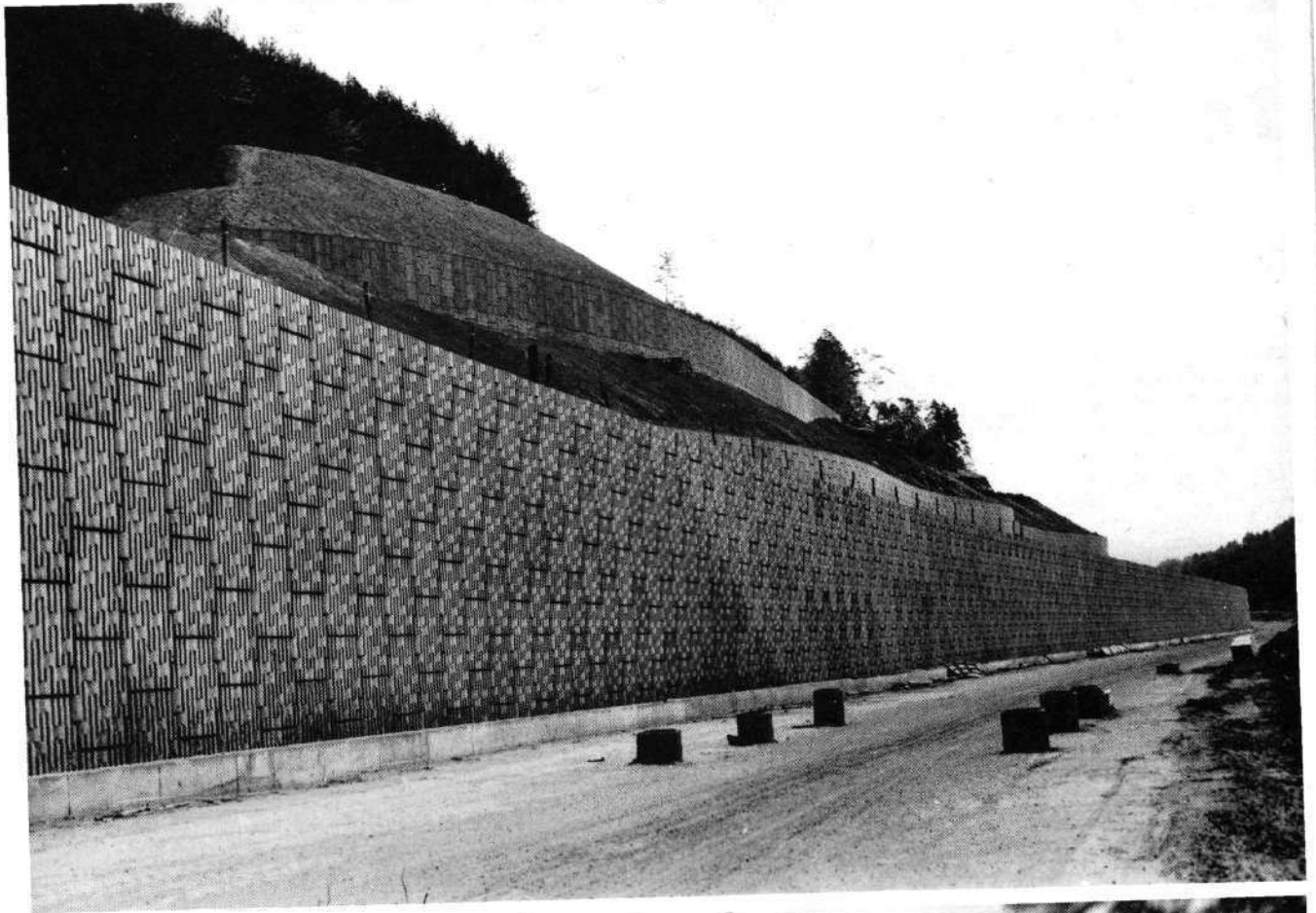
Fig. 7 : Murs de la traversée du col de Saverne. Autoroute Paris-Strasbourg
