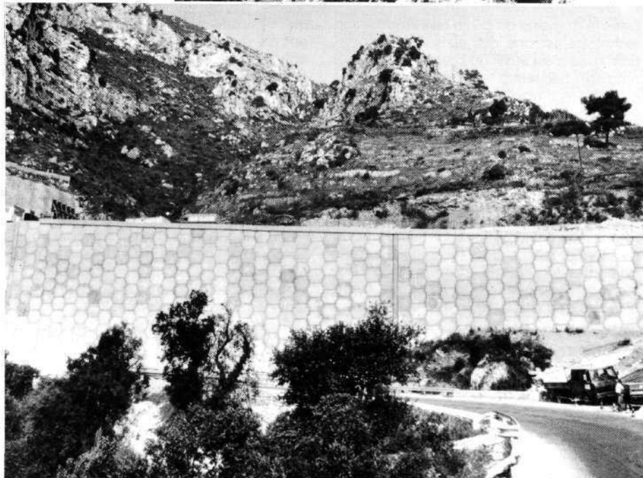
Fig. 3 : Mur de l'autoroute Nice-Menton (1978)
