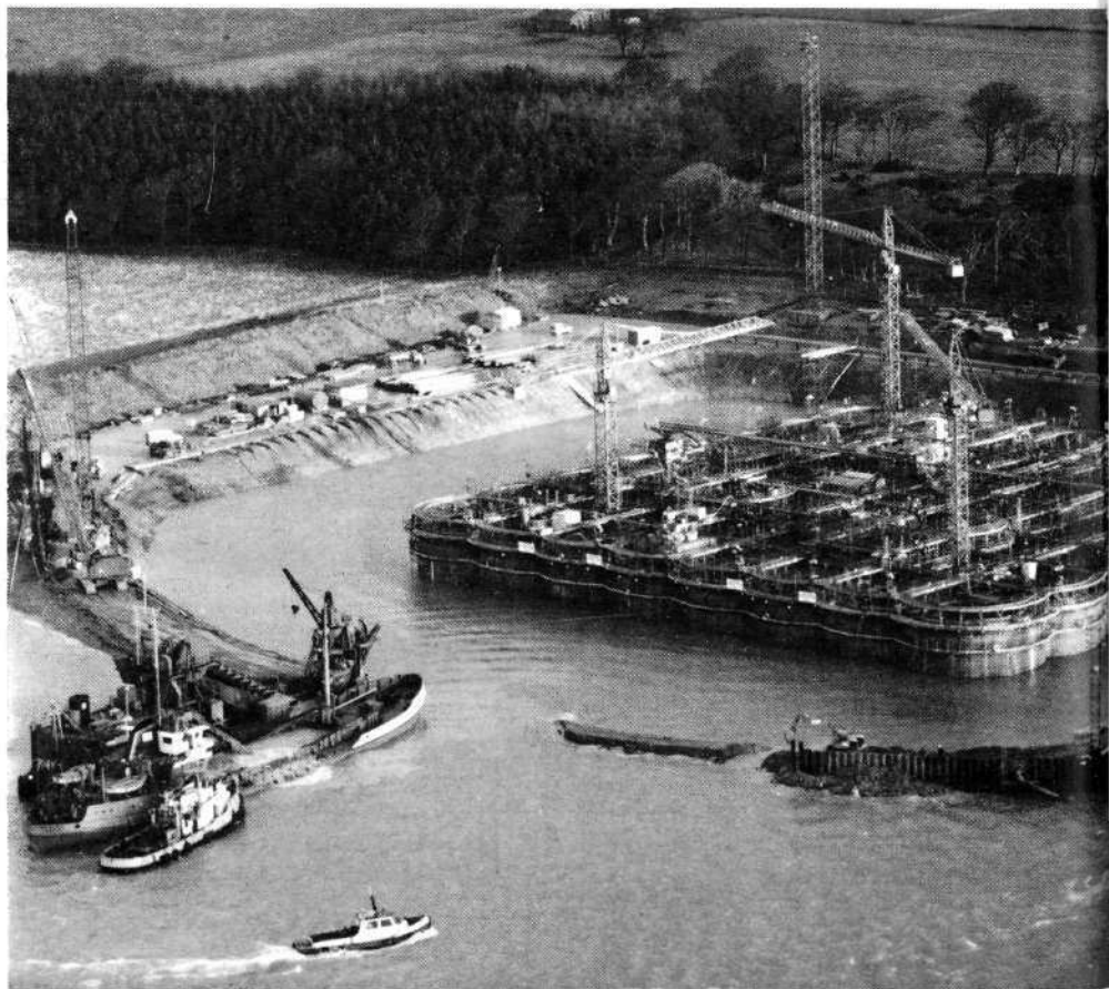
Fig. 3 - mise en place à la grue des éléments préfabriqués qui, assemblés par précontrainte dans les deux directions, raidiront le radier de 1 ère phase ; ces éléments seront ensuite noyés dans l'épaisseur du radier définitif.
