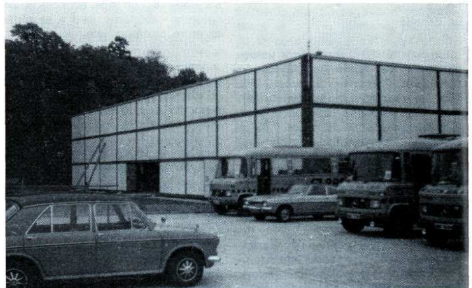
Usine modulaire en Grande-Bretagne.
