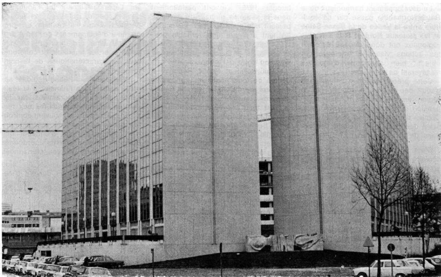
Normandie 1 et Normandie 2 : les 2 premiers immeubles de bureaux du futur Centre d'Affaires Saint-Sever à Rouen.
