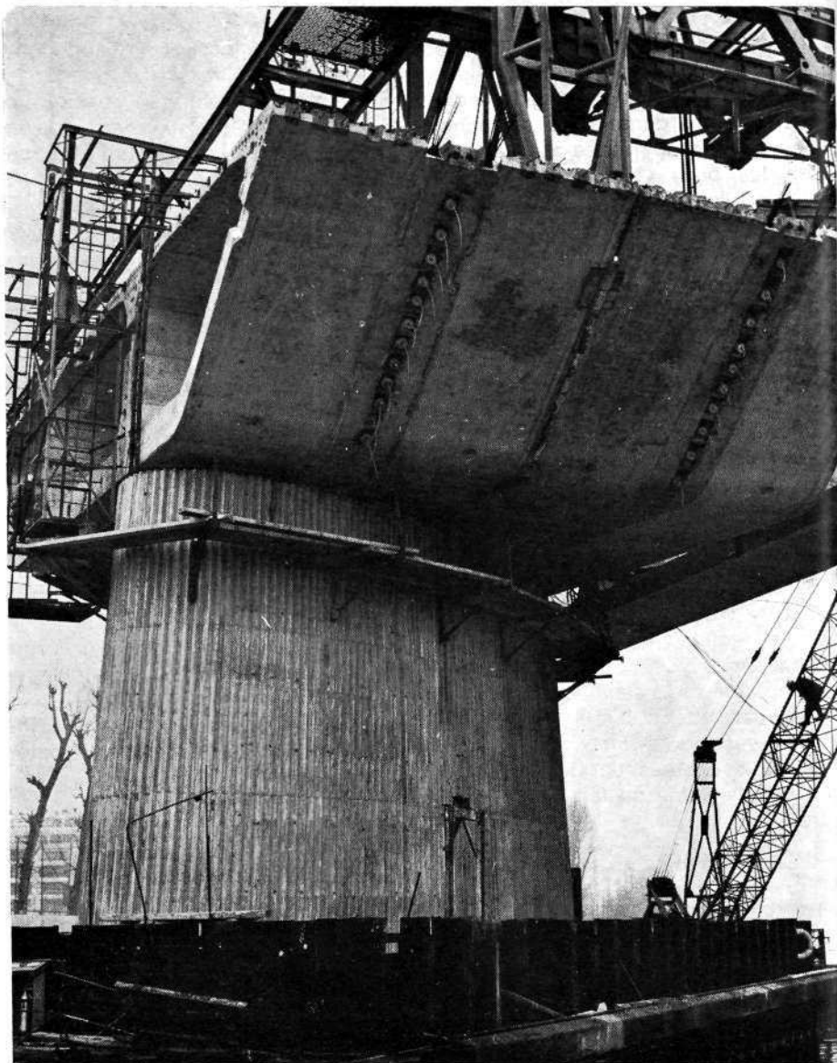
Chevêtre sur pile en Seine
