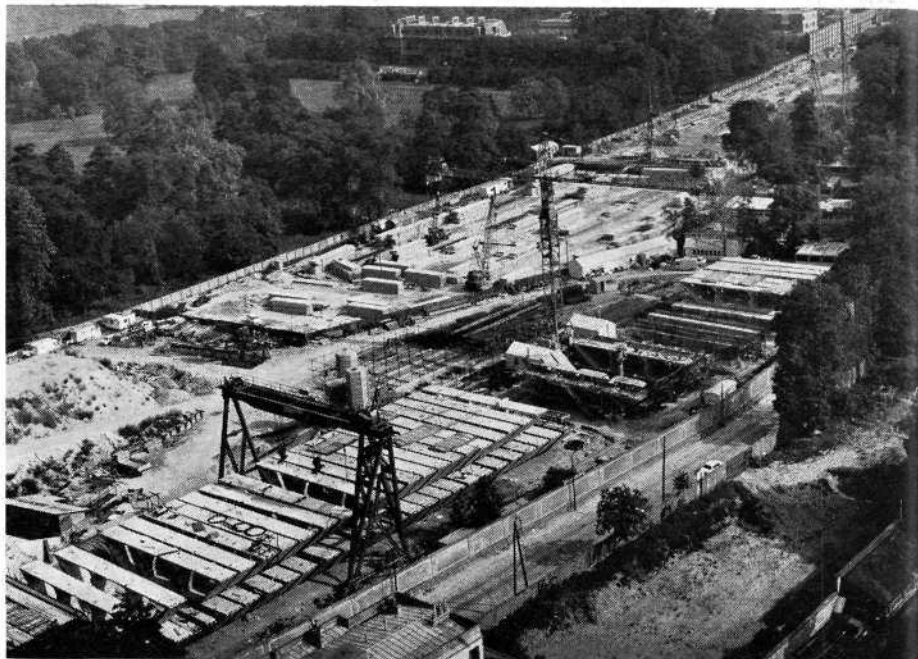
Vue du chantier de préfabrication
