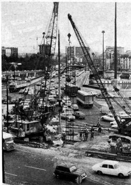
Exécution des pieux moulés (Photo Hautot)
