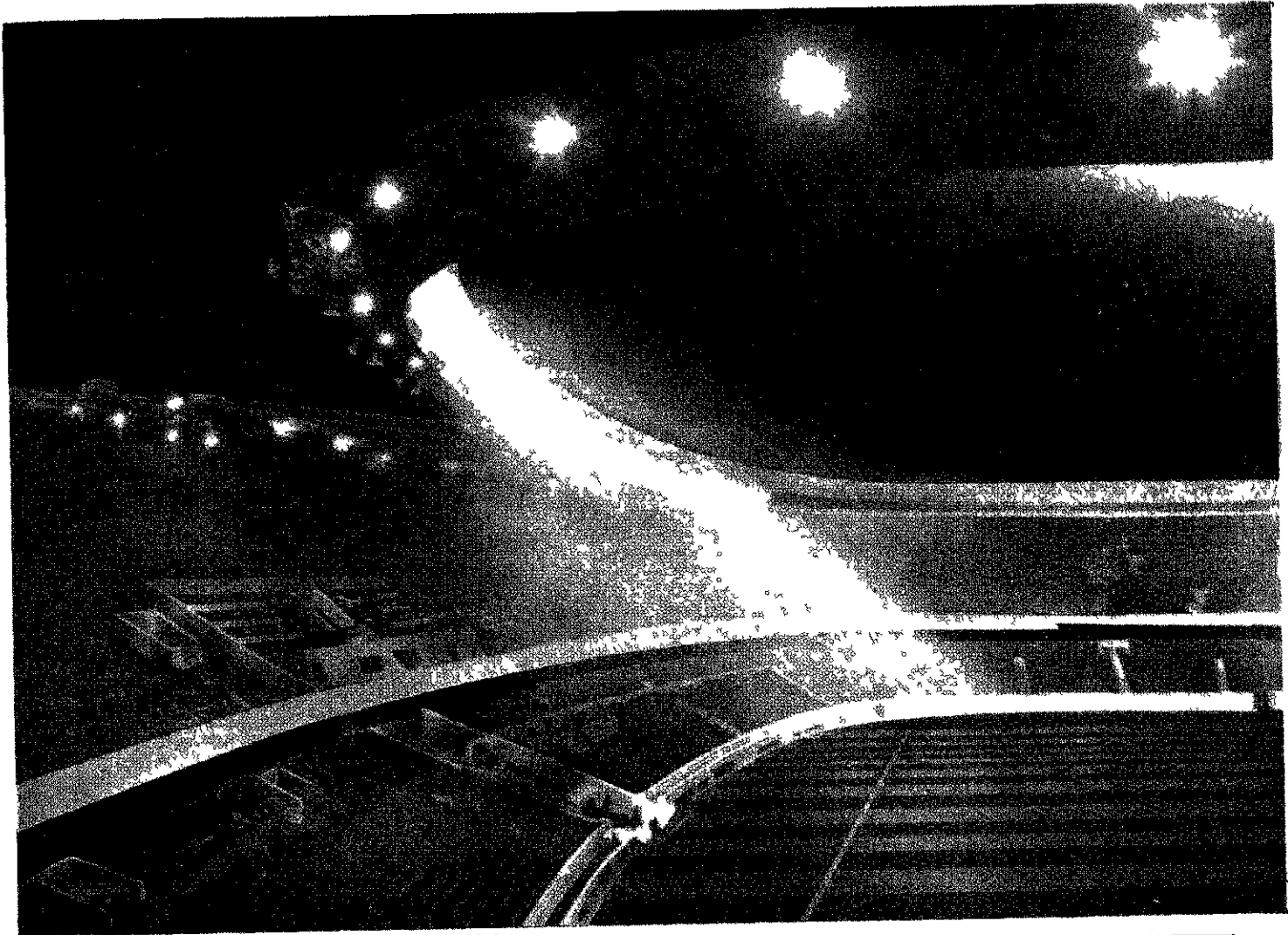
Le Parc des Princes - Installateur Verger-Delporte
