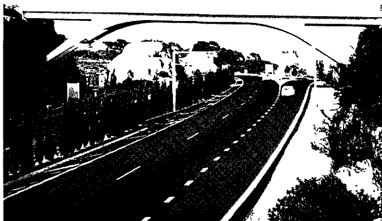
Pont à béquilles (Roquebrune-Menton)
