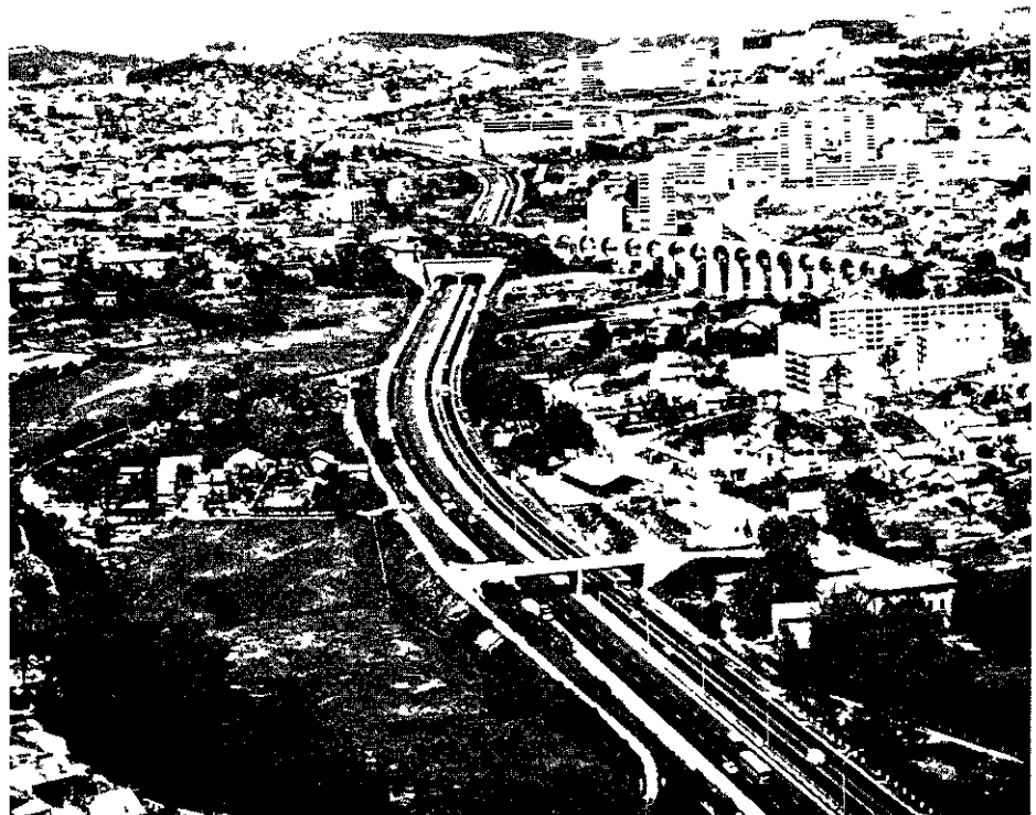
A7 — Entrée de Marseille
