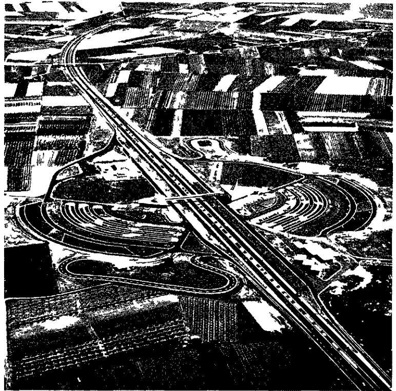
— Une aire de service (A7 - St-Rambert-d'Albon au sud de Vienne) —
