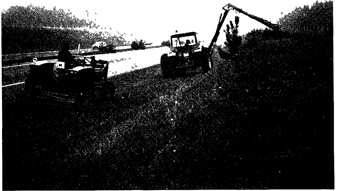
Fauchage des talus
