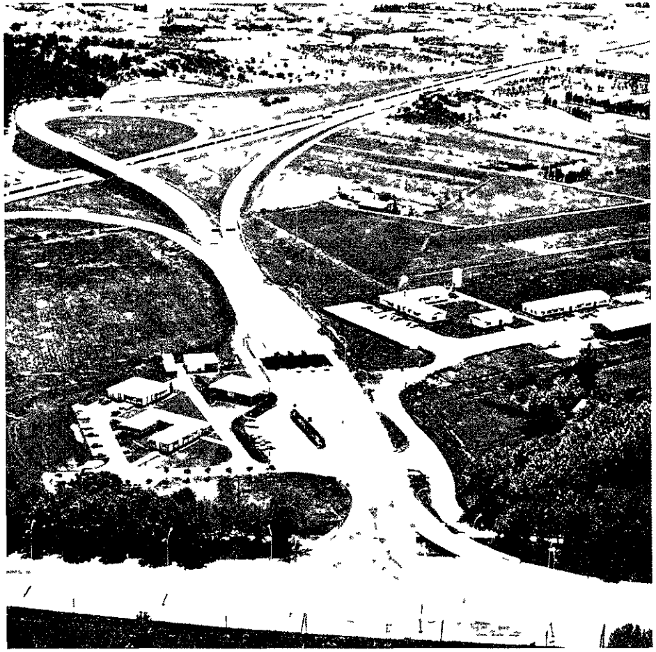
Echangeur à péage avec entrée unique (autoroute et route) (17 - Arignon-Nord)
