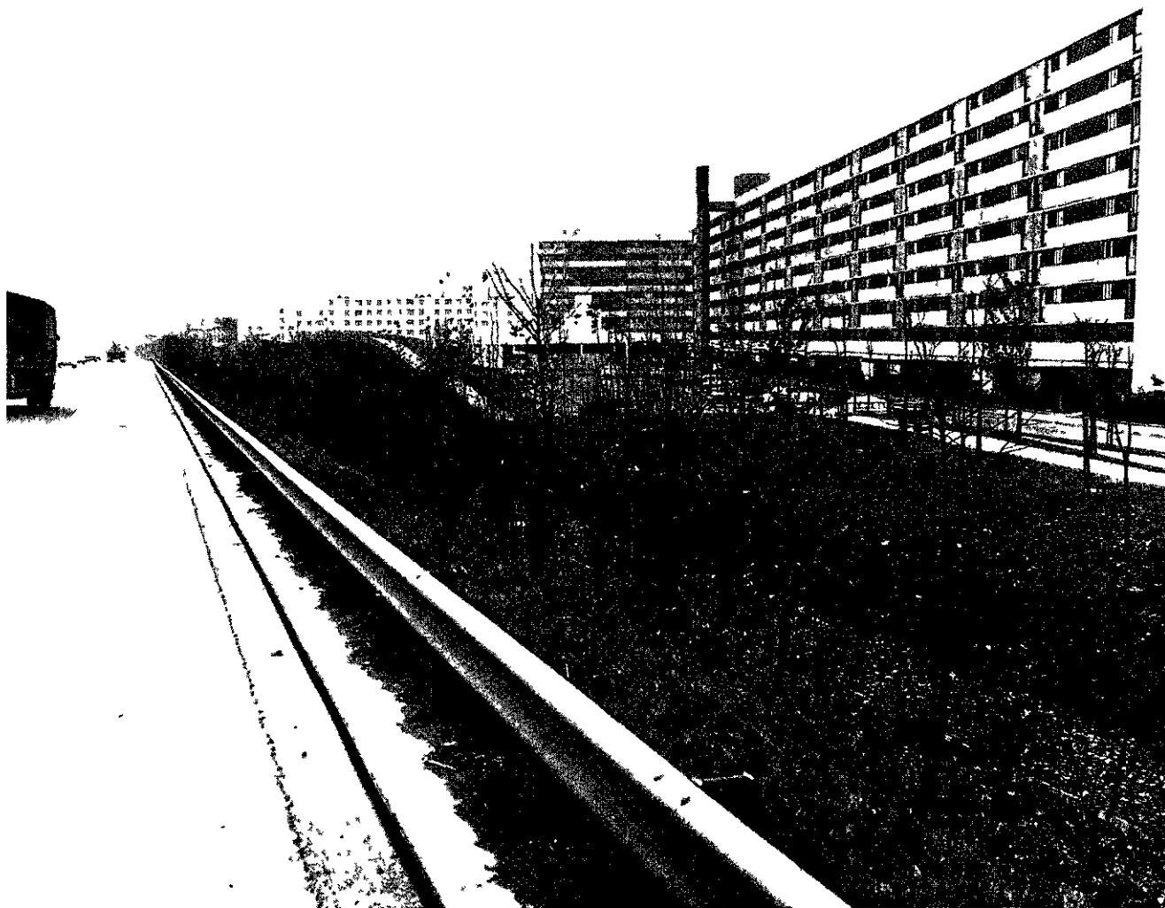
Le traitement de ce talus ne donne à l'immeuble qu'une protection illusoire contre le bruit de l'autoroute sans en améliorer pour autant l'environnement
