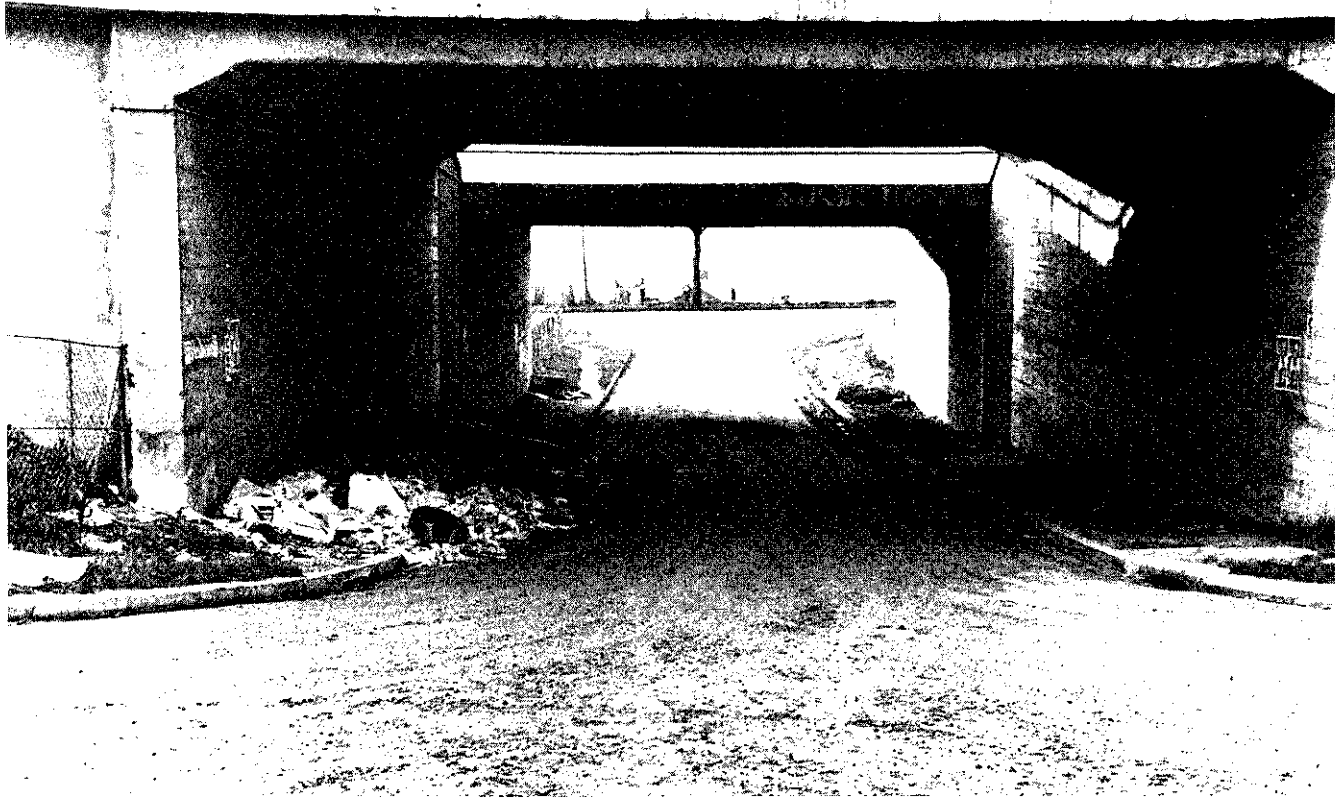
Le dessous des ouvrages, délaisse fréquent du paysage urbain
