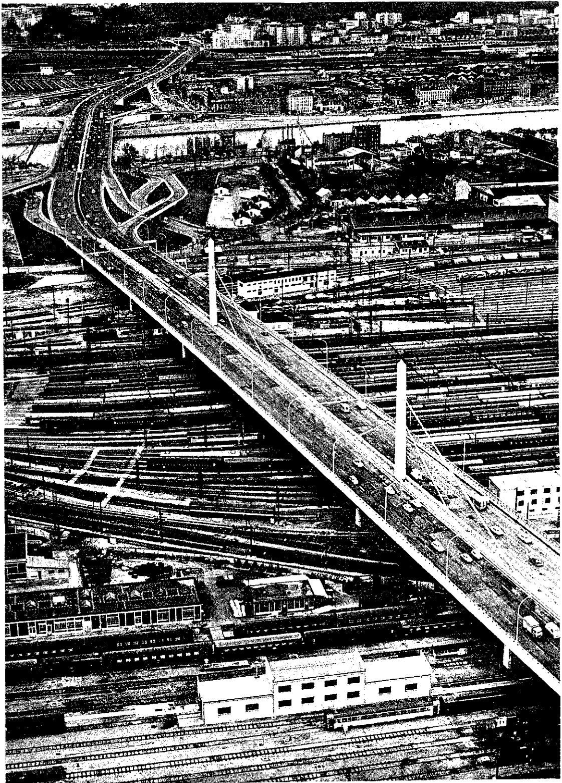
Périphérique Sud. — Franchissement des voies de gare d'Austerlitz
