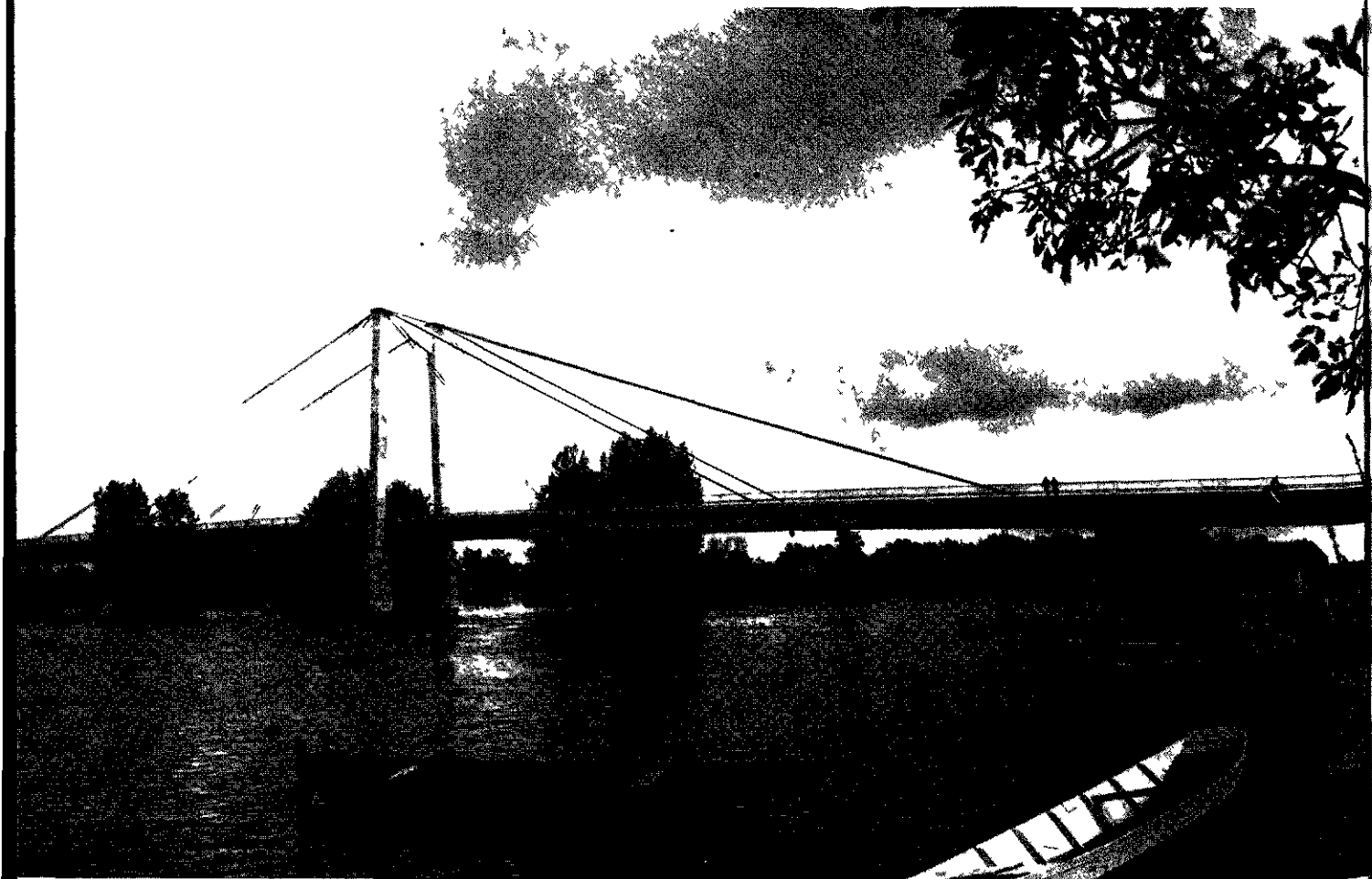
Le pont à haubans de Saint-Florent-le-Vieil sur la Loire
