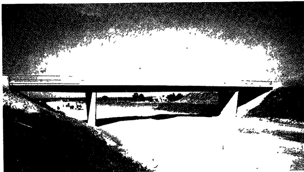
Un pont standardisé type PSOM (ouvrage mixte acier-béton)
