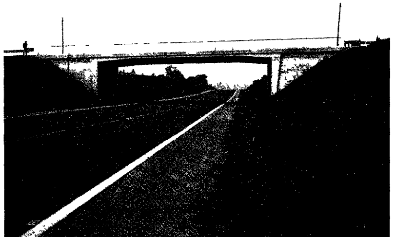
Pont-type PIPO (Portique ouvert en béton armé)
