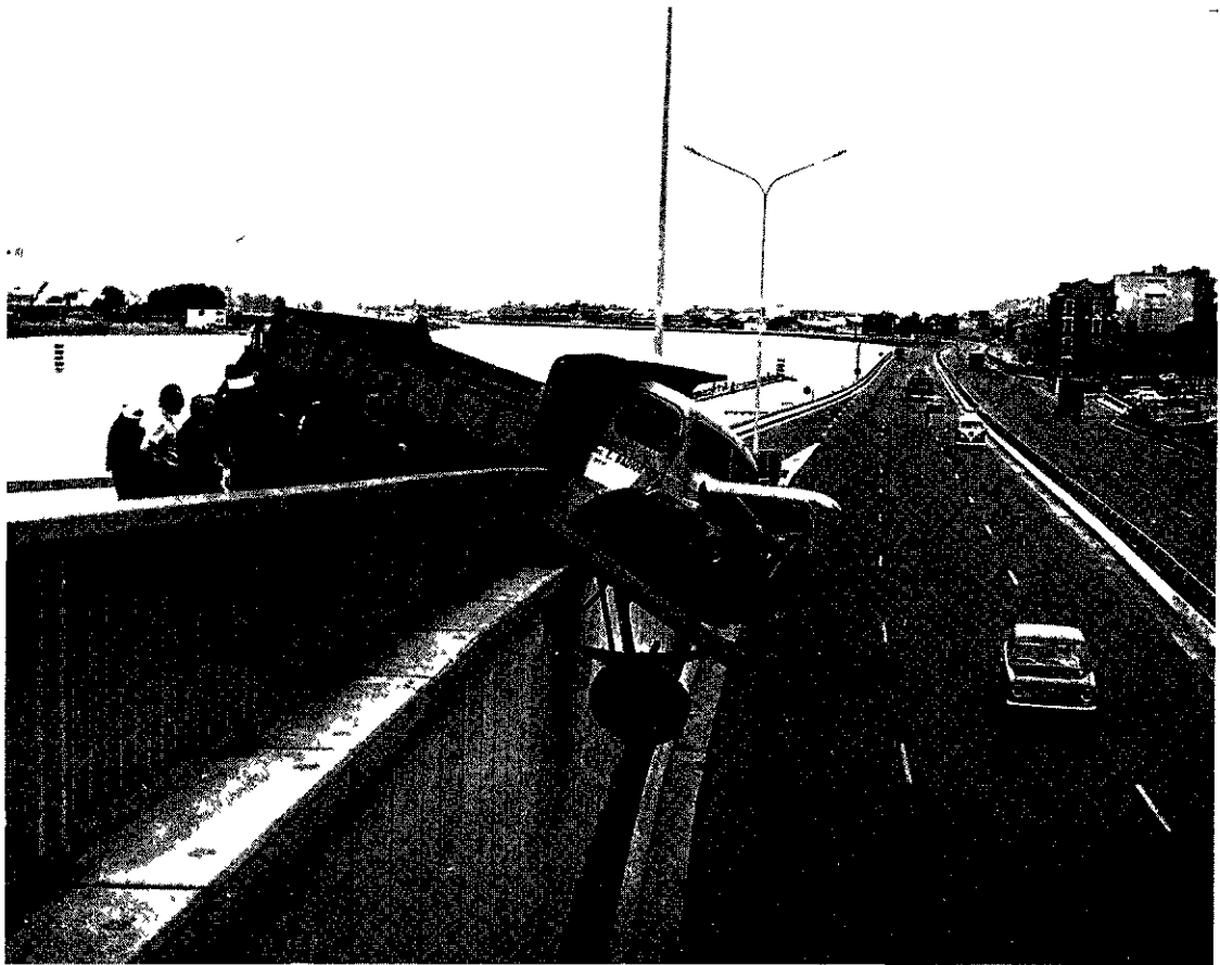
Tous les garde-corps ne peuvent pas être des barrières anti-chocs... Il faut savoir adapter leur résistance aux risques de chocs et aux conséquences d'un accident
