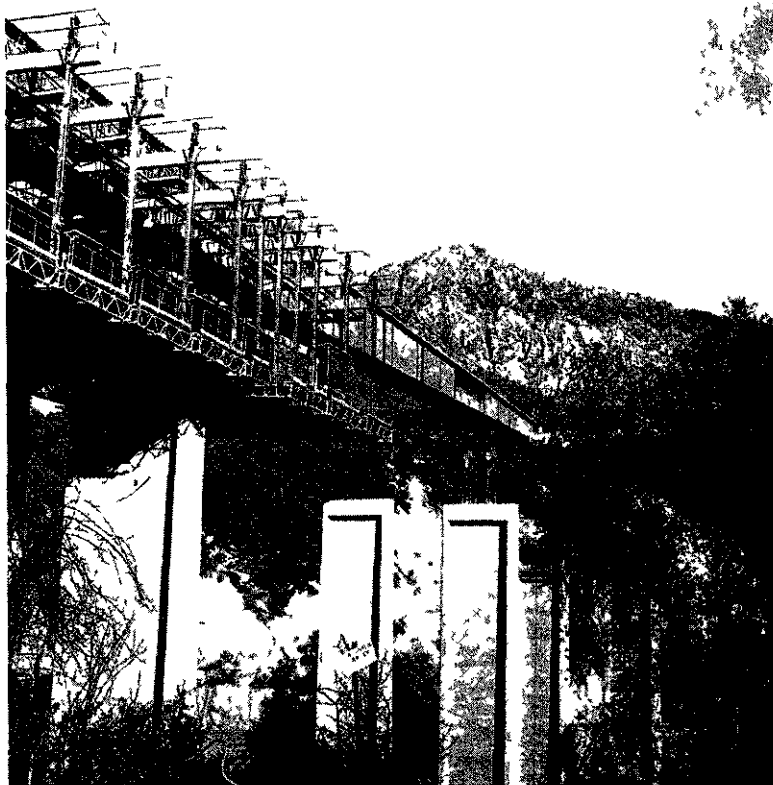
Construction d'un viaduc de l'autoroute Roquebrune-Menton sur cintre auto-portant et auto-lanceur
