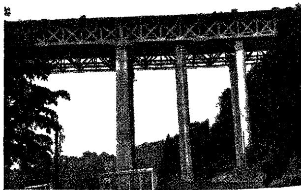
Pont réticulé en béton précontraint
