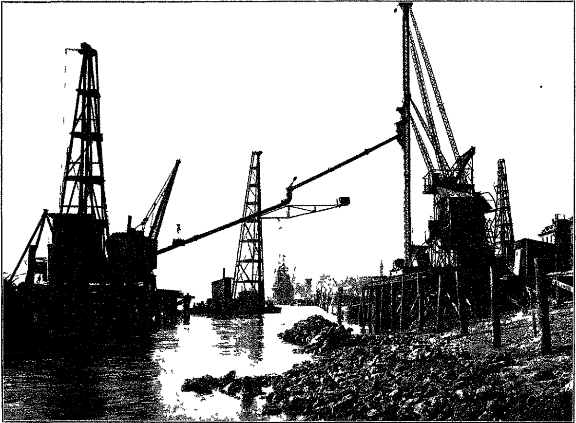
Fig. 3. — On voit, travaillant à l'avancement, la sonnette flottante qui bat le pont de service, la grue qui hâve les chemises, le mast pliant qui bétonne les chemises.
