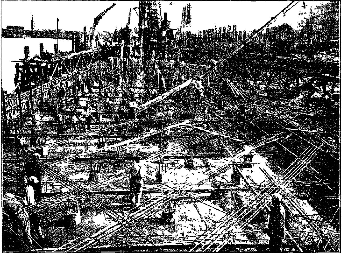
Fig 6 — Bétonnage et ferrailage de la dalle d'élagissement
